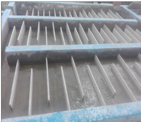
Fotografía (f). - Se observa el Floculador de C°A° con pantallas de cerámica no removibles.
