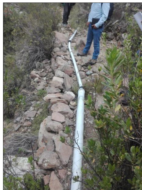
Fotografía (c). - Se observa la Línea de Conducción con Material de PVC Y F°G° con diámetros variables de 110M, 90MM, Y 63MM; además se observa las reparaciones provisionales expuestas.
