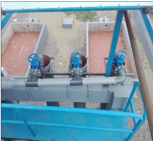
Fotografía (ñ). - Se observa la Cámara de Rejas operativa y en funcionamiento pero con material atrapado debido a la falta de limpieza.
