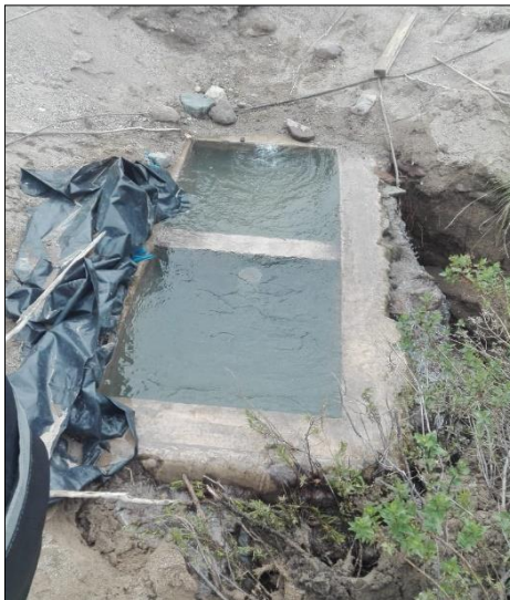
Fotografía (b). - Se observa la estructura del desarenador de C°A° colmatado y deteriorado de sección interior Ancho=1.00M, Largo= 2.00M; E=0.15M
