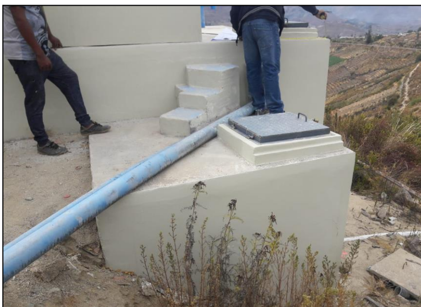
Fotografía (i). - Se observa el R-1, donde llega el agua de la PTAP para su almacenamiento
