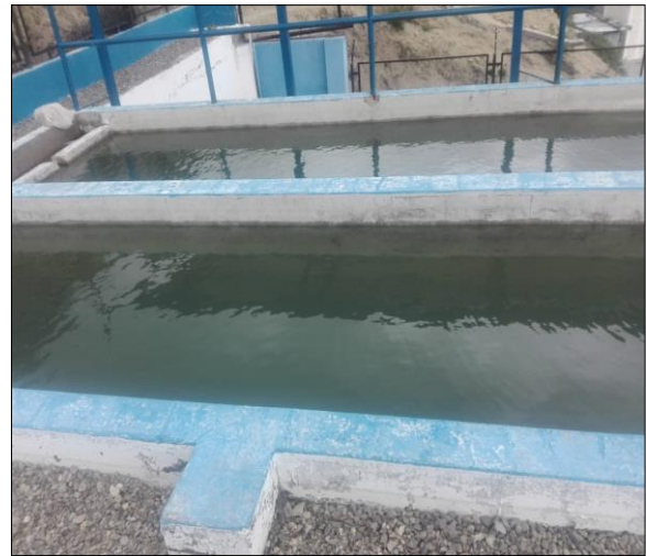
Fotografía (e). - Se observa el Sedimentador o Decantador de 2 Cámaras en Paralelo.
