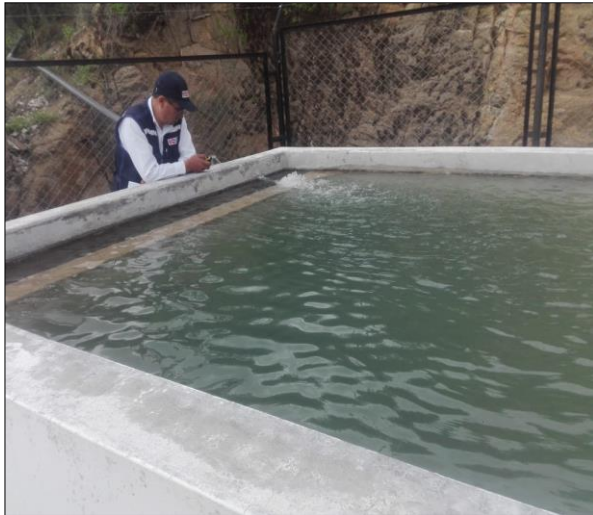
Fotografía (d). - Se observa el Desarenador con ingreso donde llega el agua captada con un flujo turbulento.
