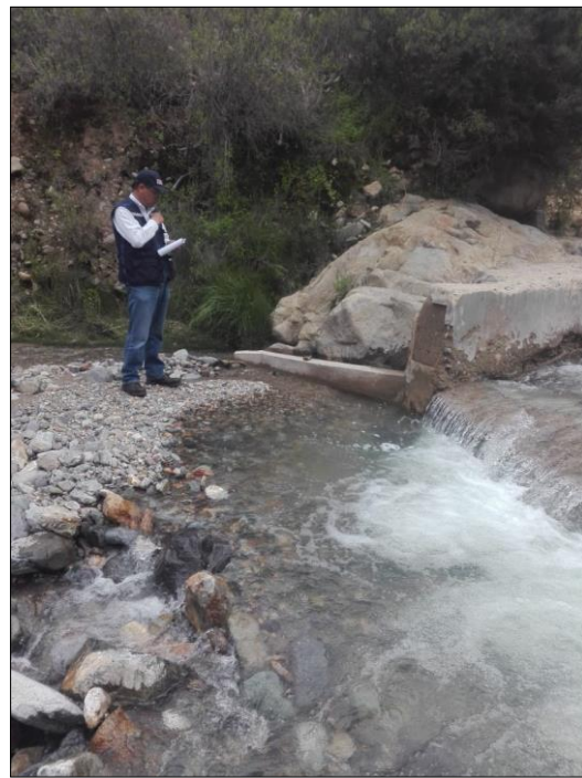
Fotografía (a). - Se observa la toma lateral por medio de una tubería de PVC, que dirige al canal de derivación de 0.20 X 0.20 m de sección interior de C°A°
