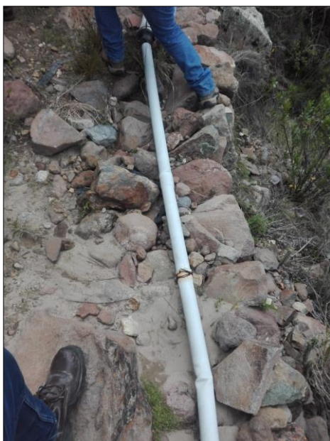
Fotografía (c). - Se observa la Línea de Conducción con Material de PVC Y F°G° con diámetros variables de 110M, 90MM, Y 63MM; además se observa las reparaciones provisionales expuestas.
