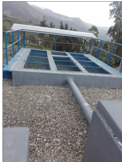
Fotografía (n). - Se observa El Tanque Imhoff puesta en funcionamiento.
