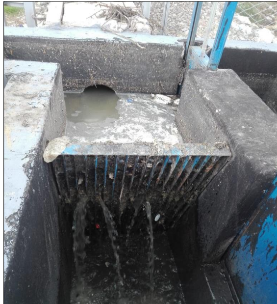
Fotografía (ñ). - Se observa la Cámara de Rejas operativa y en funcionamiento pero con material atrapado debido a la falta de limpieza.
