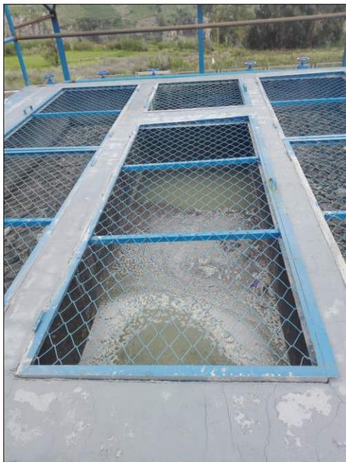
Fotografía (n). - Se observa El Tanque Imhoff puesta en funcionamiento.
