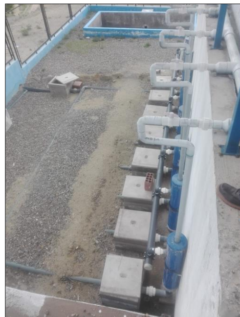
Fotografía (g). - Se observa los filtros no convencionales con deficiencias en su funcionamiento
