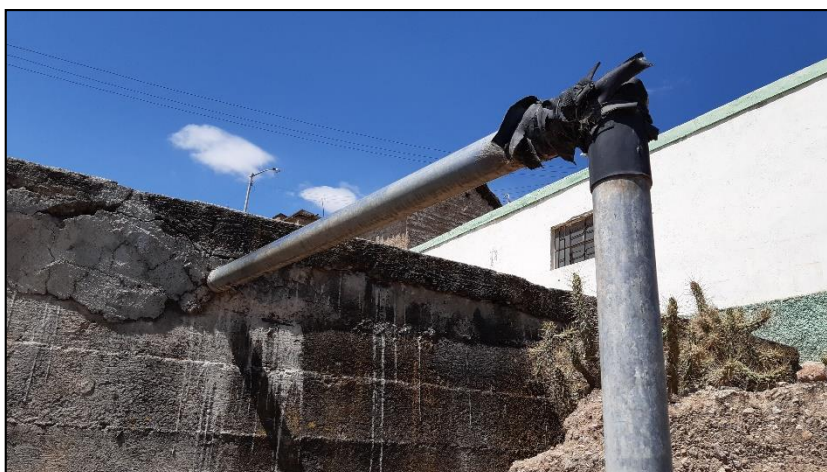
Fotografía (k). - Se observa el ingreso de agua tratada del R-1 hacia el R-2
