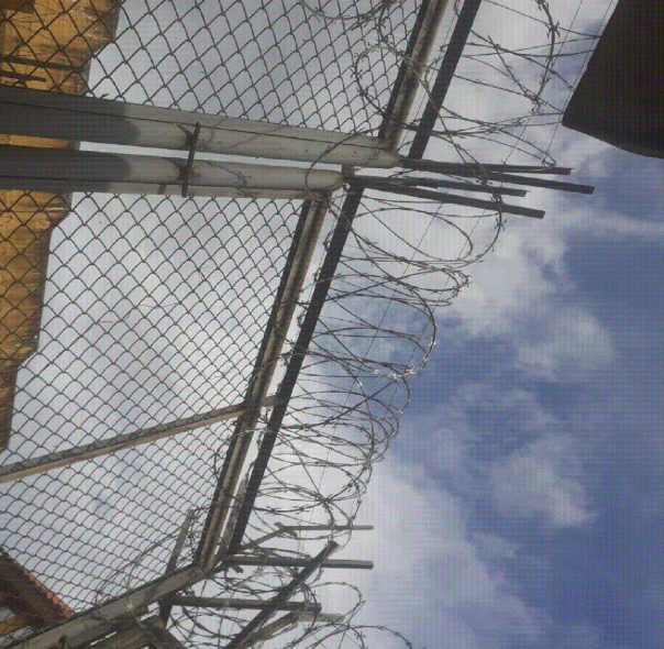
MANTENIMIENTO DE CERCO METALICO CON MALLAS DE COCADA 2"x2". ENTRE TIERRA DE NADE Y PISTA PANTADO DE ESTRUCTURA METALICA TUBULAR DE 27.3" Y MARCO DE MALLA DE ANGULOS DE 1 1/2" x 1 1/2" (PAÑO DE H=3.05m, ANCHO=2.95m)
