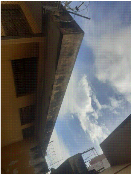
MANTENIMIENTO DE CONCRETINAS EN CORREDOR HACIA CELDAS DE AISLAMIENTO Y TALLERES DE CARPINTERIA SUMINISTRO E INSTALACION DE CONCRETINAS DE ACERO INOXIDABLE DIAM. 24", E=33CM (INCLUYE TENSORES DE ACERO INOXIDABLE E=3MM, SOPORTEPARANTE METALICO DE ANGULO DE 1 1/2" @ 1.50M).
