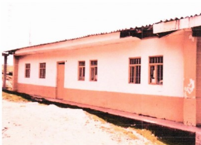
Foto 02. Se observa pintura exterior en mal estado
