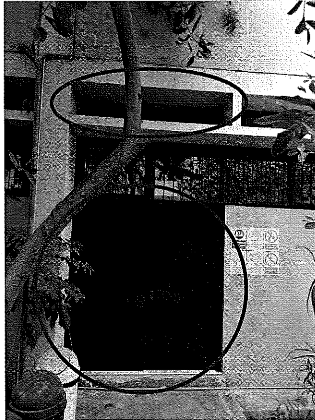
Fotografía 5. Instalación de puerta nueva contraplacada y protectores metálicos para puerta y ventana en el edificio B 07
