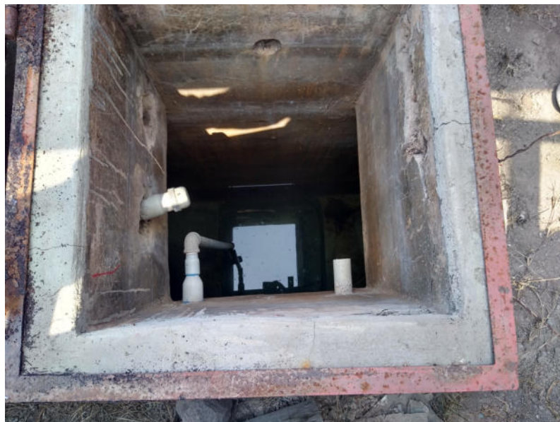
Fotografía 58: Cisterna en malas condiciones, sin mantenimiento, se observa tapa metálica oxidada, sin escalera de gato y paredes con tarrajeo pulido desprendido y fisuras.
