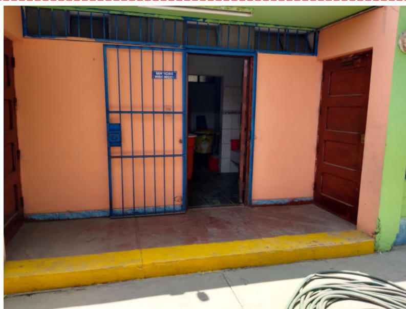
Fotografía 41: Elevación 03, Ingreso a la Unidad de SSHH 03 Módulo 06 y 07 (baño de damas inicial), se verifica el regular estado de la puerta principal de ingreso y rejas metálicas en la fachada. Asimismo, se observa ventanas metálicas con signos de corrosión y presencia de vidrios crudos sin láminas de seguridad, además de las luminarias existentes en mal estado.
