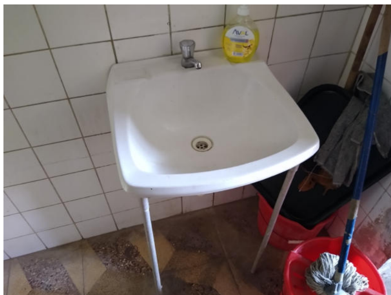
Fotografía 49: Módulo 07 (baño damas docentes de inicial). Se observa el lavatorio de loza vitrificada sin pedestal en regular estado. Asimismo, se evidencia el mal estado del enchape en piso y pared, además de no contar con un espacio para el almacenamiento de los artículos de limpieza.
