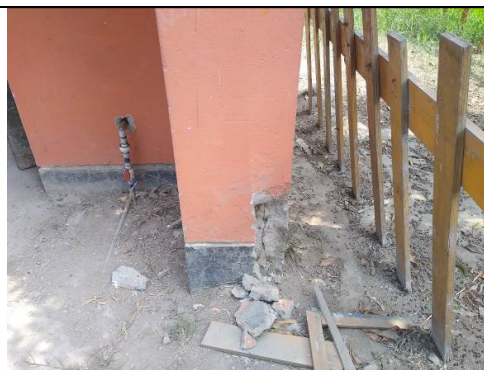
DAÑO ESTRUCTURAL EN COLUMNA
