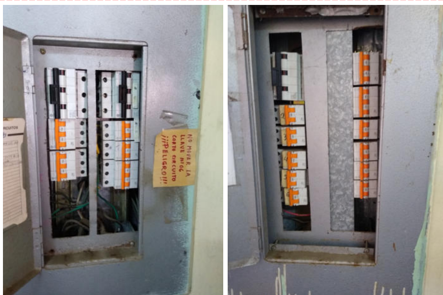
Fotografía 61: Tableros eléctricos (TG y TD-01) ubicados en la Edificación EP01, donde se evidencia que se encuentra en malas condiciones, sin trabajos de mantenimiento. No registra interruptores diferenciales.
