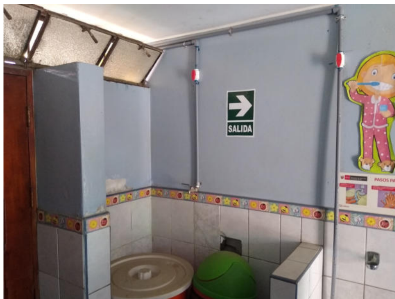
Fotografía 38: Módulo 05 (baño damas estudiantes de inicial). Se evidencia el deterioro de la pintura por la humedad y el salitre, así como tubos de PVC de agua fría sin empotrar.
