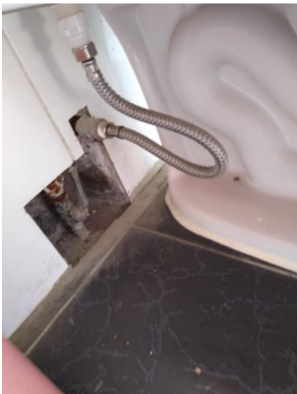
Fotografía 27: Módulo 04 (baño damas docentes de primaria). Se evidencia el deterioro en válvulas de compuerta con uniones universales oxidadas.
