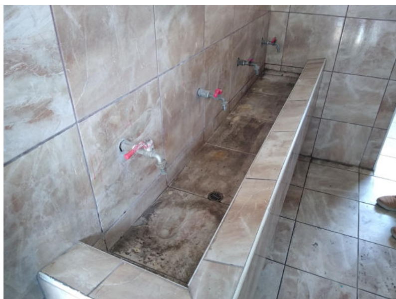
Fotografía 09: Módulo 01 (baño varones estudiantes de primaria). Se evidencia el buen estado del enchape cerámico del lavatorio corrido; sin embargo, las griferías se encuentran deterioradas.
