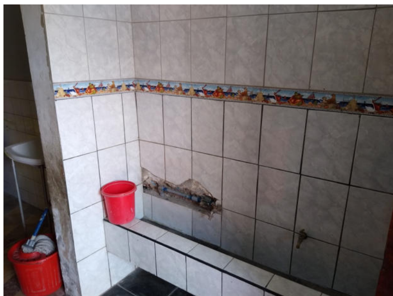
Fotografía 43: Módulo 06 (baño varones estudiantes de inicial). Se evidencia el deterioro en las conexiones, grifería y enchape de paredes en lavatorio corrido.
