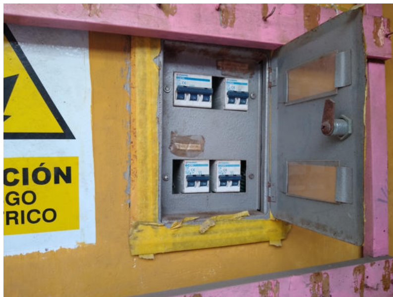
Fotografía 40: Módulo 05 (baño damas estudiantes de inicial). Gabinete de Subtablero 01 en mal estado, sin leyenda e interruptores termomagnéticos deteriorados.
