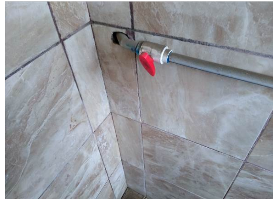
VALVULA DE URINARIO EN BUEN ESTADO DEL M1
