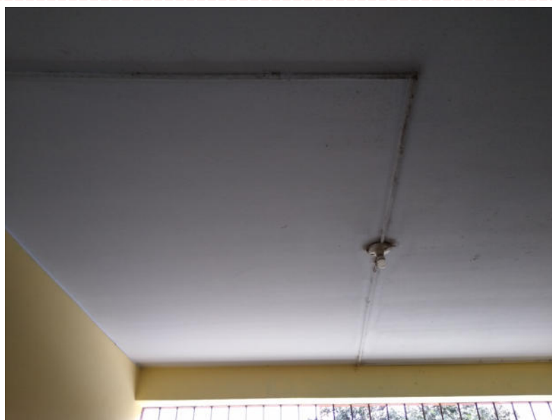
Fotografía 11: Módulo 01 (baño varones estudiantes de primaria). Se evidencia el uso de canaletas de PVC lo cual transporta los cables para el encendido de una luminaria, las cuales se encuentran en mal estado. Luminaria inadecuada y deteriorada.
