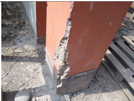
DAÑO ESTRUCTURAL EN COLUMNA
