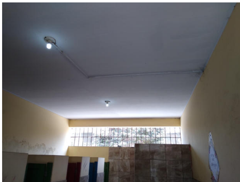
Fotografía 16: Módulo 02 (baño damas estudiantes de primaria). Se evidencia el uso de canaletas de PVC lo cual transporta los cables para el encendido de una luminaria, las cuales se encuentran en mal estado. Luminaria inadecuada y deteriorada.
