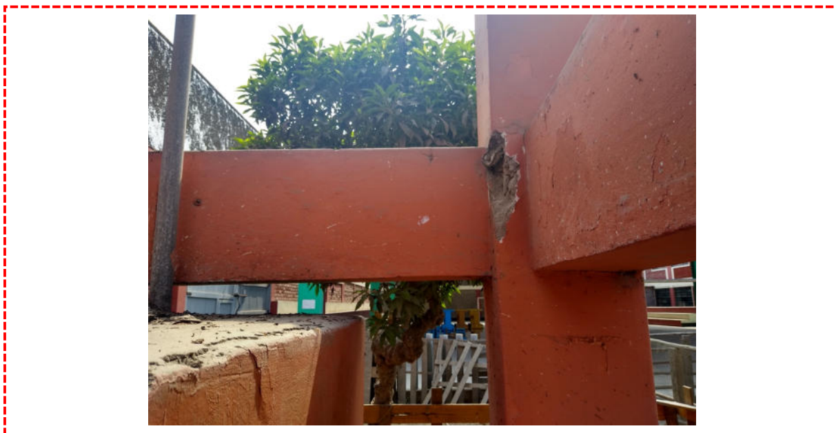
Fotografía 56: Elevación 06, tanque elevado de concreto existente (primaria). Se evidencia que existían problemas de filtración cuando estaba en uso, así mismo la presencia de múltiples agrietamientos y fisuras en estructura de soporte.
