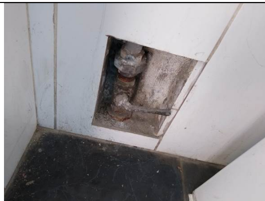
VALVULA CONTROL EN MAL ESTADO M3
