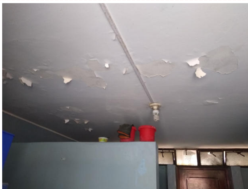
Fotografía 37: Módulo 05 (baño damas estudiantes de inicial). Se evidencia en el cielo raso el deterioro de la pintura por salitre y presencia de filtraciones. Luminaria inadecuada y deteriorada.
