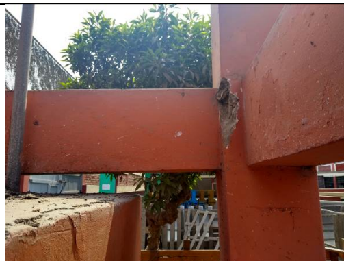
DAÑO ESTRUCTURAL EN VIGA
