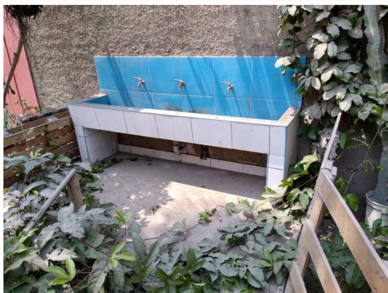
Fotografía 51: Vista del lavatorio externo donde se evidencia el regular estado del enchape cerámico y el mal estado de las griferías.
