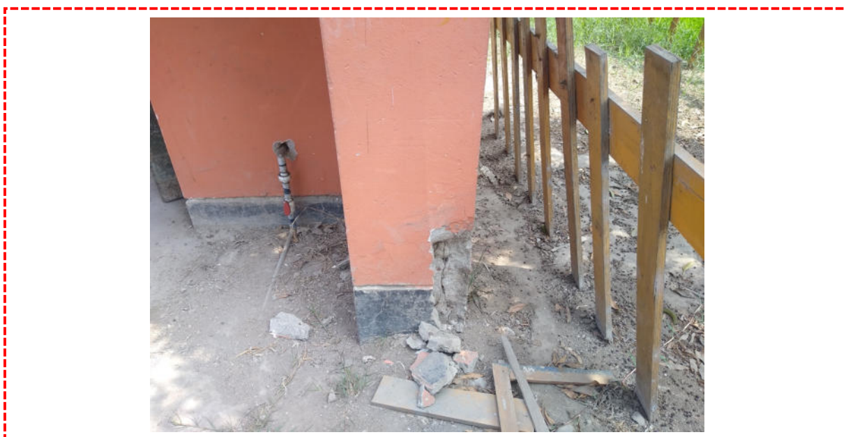
Fotografía 57: Base de tanque elevado de concreto existente (primaria), se encuentra deteriorado desprendiéndose el concreto y exponiendo el acero de refuerzo que se encuentra corroído, por sus condiciones representa un riesgo.
