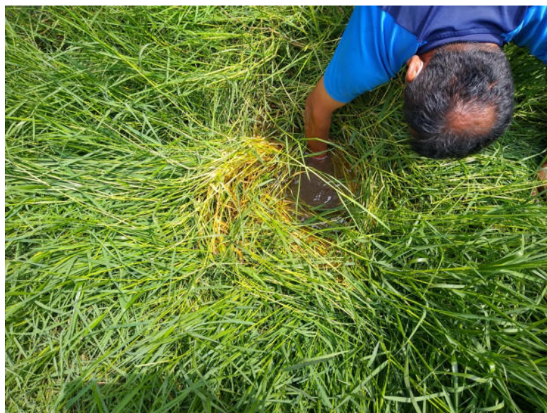
Fotografía 60: By pass de ingreso de agua desde la red pública. Se evidencia que no cuenta con tapa y cuya visualización de su estado se afecta por el área verde que no recibe mantenimiento.
