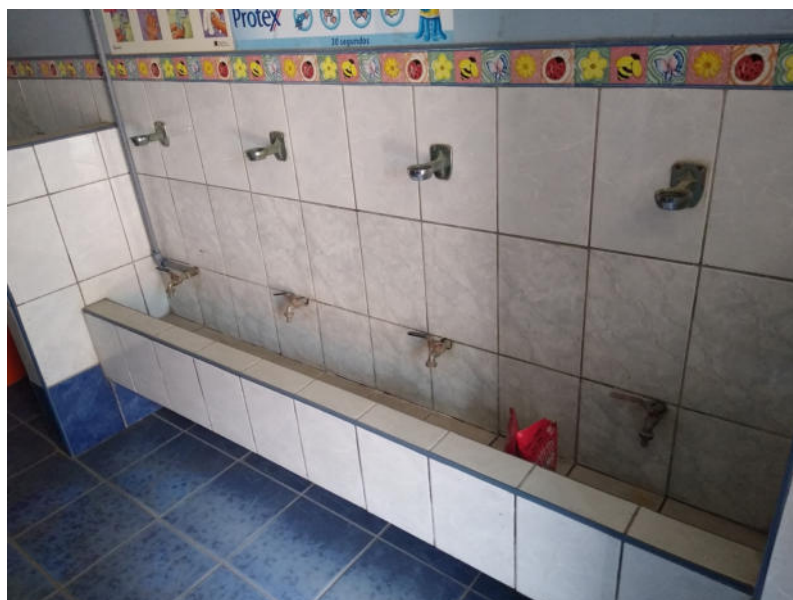
Fotografía 33: Módulo 05 (baño damas estudiantes de inicial). Se evidencia el mal estado de las conexiones en lavatorio y grifería, así como de los accesorios para dispensadores de jabón líquido.
