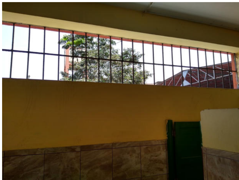
Fotografía 12: Módulo 01 (baño varones estudiantes de primaria). Ventanas de rejas metálicas con signos de corrosión y desprendimiento de pintura esmalte, y sin vidrios.
