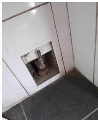
VALVULA CONTROL EN MAL ESTADO M4
