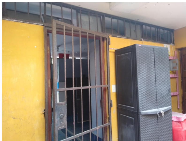
Fotografía 39: Módulo 05 (baño damas estudiantes de inicial). Puerta y ventanas posteriores de rejas metálicas en pésimas condiciones, totalmente corroídas.
