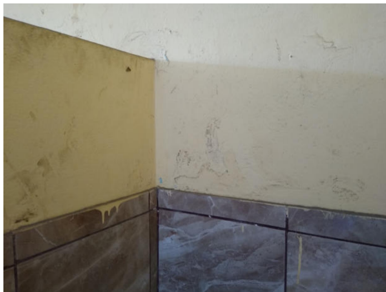
Fotografía 10: Módulo 01 (baño varones estudiantes de primaria). Se evidencia el deterioro moderado de pintura, afectado por la humedad.
