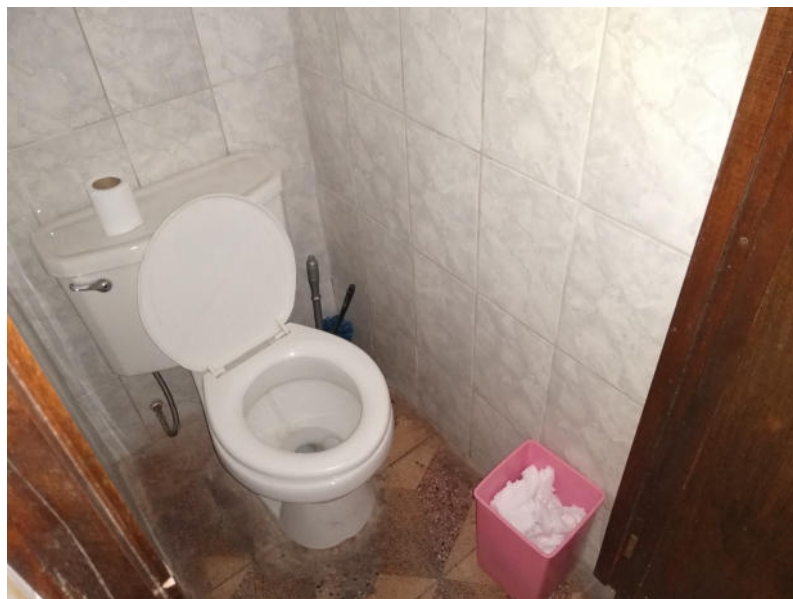
Fotografía 48: Módulo 07 (baño damas docentes de inicial). Se observa el inodoro en buenas condiciones; sin embargo se evidencia el mal estado del piso de loseta de concreto con la puerta de madera del cubículo.
