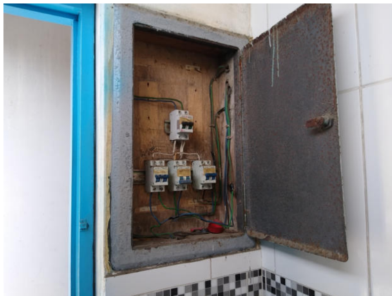
Fotografía 22: Módulo 03 (baño varones docentes de primaria). Se evidencia la existencia de un tablero eléctrico el cual se encuentra en mal estado y se debe reubicar.
