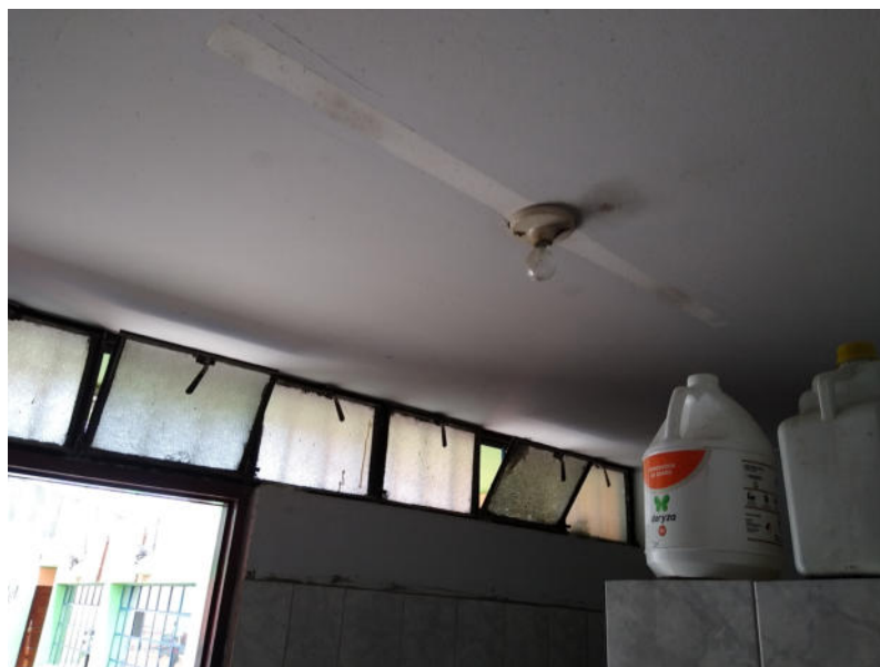
Fotografía 44: Módulo 06 (baño varones estudiantes de inicial). Se verifica las malas condiciones de las instalaciones eléctricas y ventanas.
