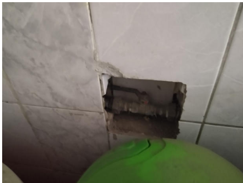
Fotografía 36: Módulo 05 (baño damas estudiantes de inicial). Se evidencia las pésimas condiciones de las válvulas de compuerta (no funcionan)
