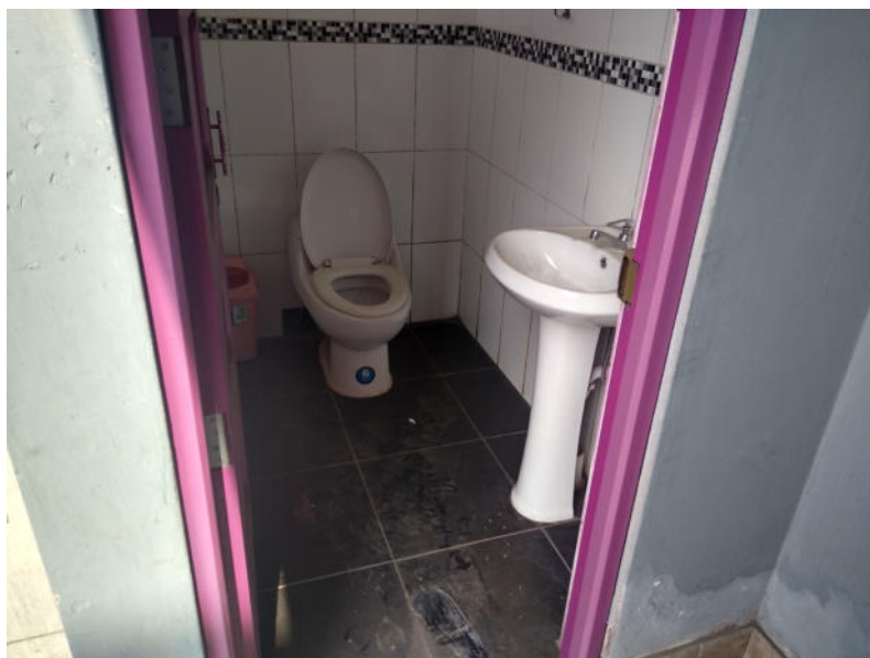
Fotografía 24: Módulo 04 (baño damas docentes de primaria), se evidencia el buen estado del inodoro y el lavatorio con pedestal; así como del cerámico de piso y pared. La fragua del enchape cerámico se observa que se encuentra en regular estado.
