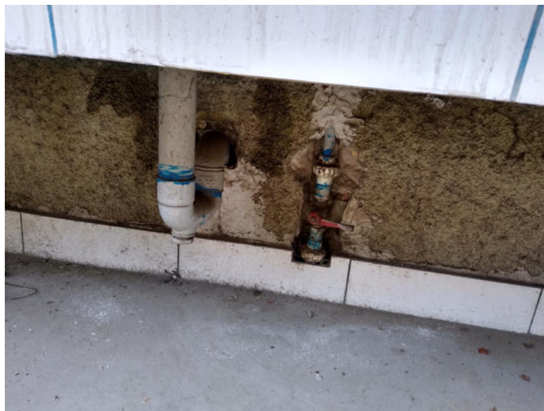
Fotografía 52: Tarrajeo deteriorado por la humedad debajo del lavatorio externo. Además, se visualiza el mal estado de la válvula de compuerta.
