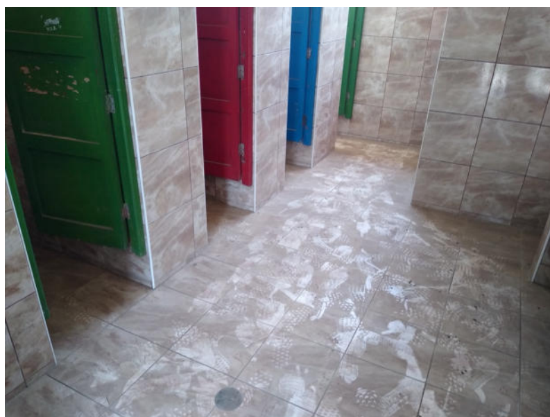
Fotografía 13: Módulo 02 (baño damas estudiantes de primaria), se evidencia el buen estado del enchape cerámico en zócalos y pisos. Asimismo, se muestra el estado regular de las puertas de madera en los cubículos.
