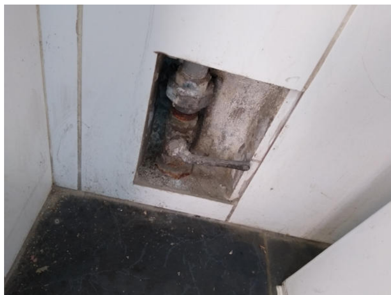
Fotografía 23: Módulo 03 (baño varones docentes de primaria). Se muestra válvula de compuerta y uniones universales en mal estado.
