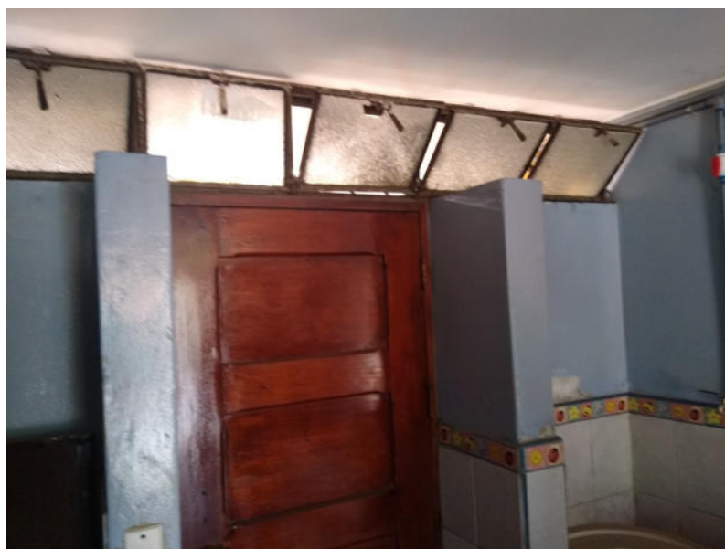
Fotografía 32: Módulo 05 (baño damas estudiantes de inicial). Se verifica las malas condiciones de ventanas y vidrios sin láminas de seguridad, deterioro de pintura en muros y enchape de zócalos. Puerta de madera en regular estado.
