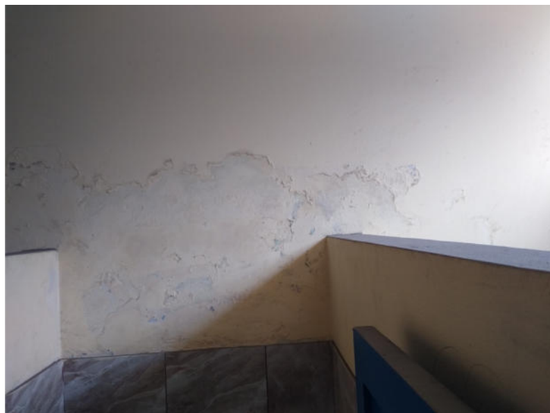
Fotografía 18: Módulo 02 (baño damas estudiantes de primaria). Se evidencia el deterioro moderado de la pintura debido a la humedad y el salitre.
