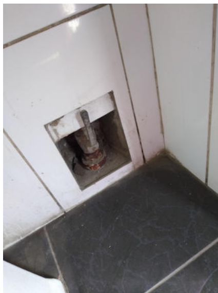
Fotografía 27: Módulo 04 (baño damas docentes de primaria). Se evidencia el deterioro en válvulas de compuerta con uniones universales oxidadas.
