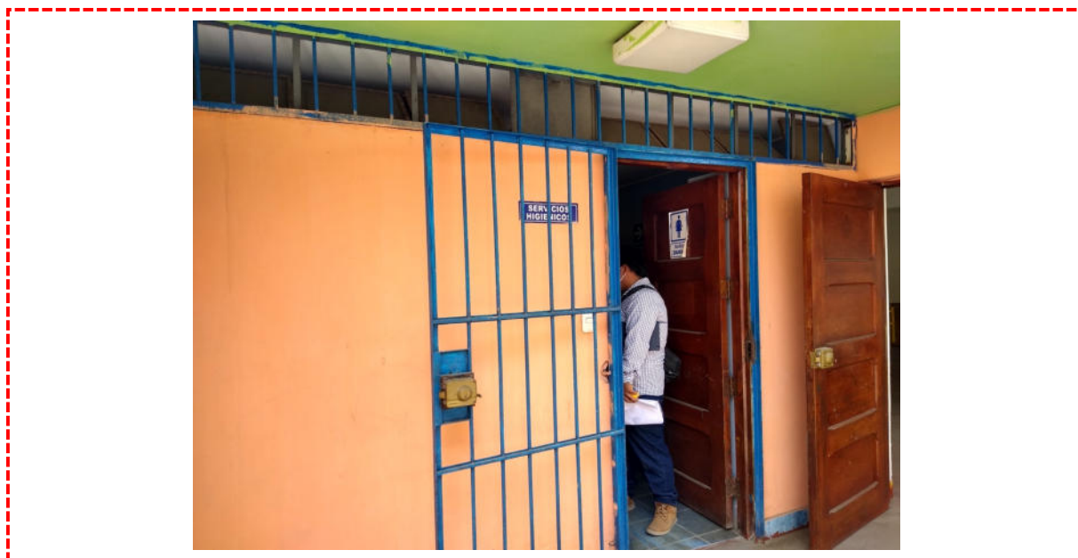
Fotografía 28: Elevación 02, Ingreso a la Unidad de SSHH 02 Módulo 05 (baño de damas inicial), se verifica el regular estado de la puerta principal de ingreso y rejas metálicas en la fachada. Asimismo, se observa ventanas metálicas con signos de corrosión y presencia de vidrios crudos sin láminas de seguridad.
