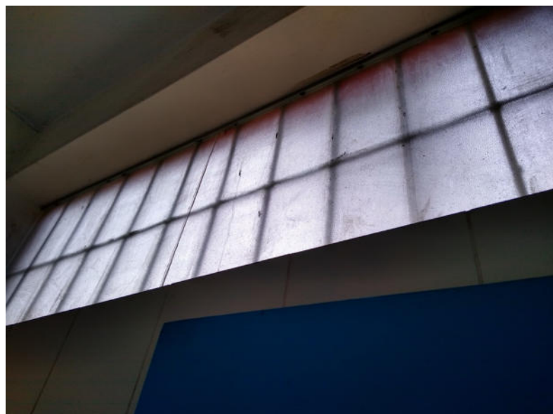
Fotografía 21: Módulo 03 (baño varones docentes de primaria), presencia de vidrios crudos sin laminar; así como carpintería metálica con signos de corrosión.
