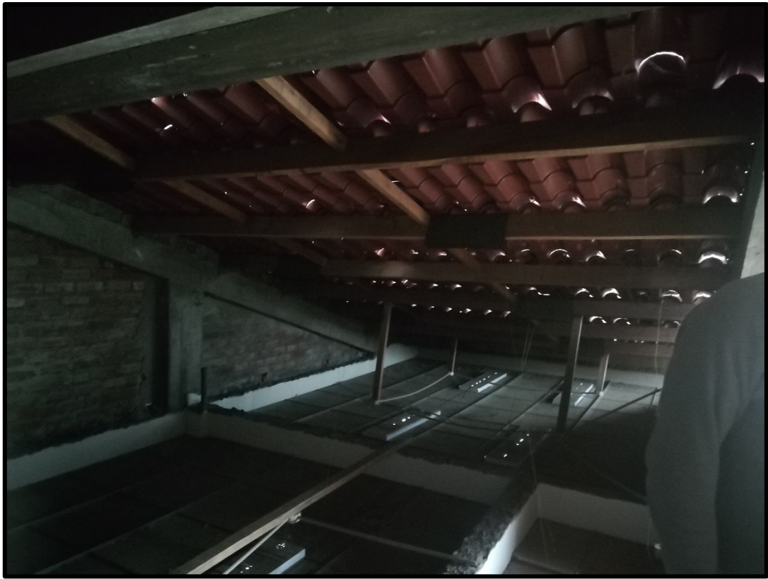
Foto 03: Vigas de Amarre de Madera Existente
