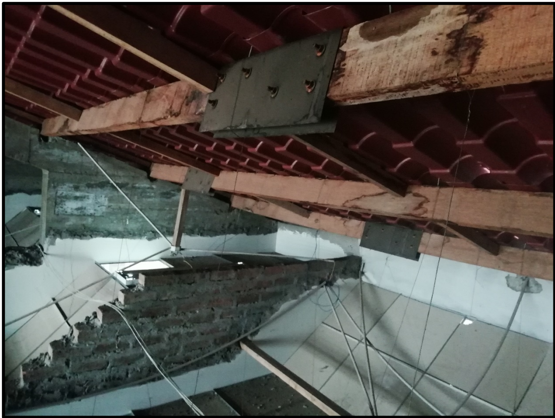
Foto 02: Unión en Correas de Madera
