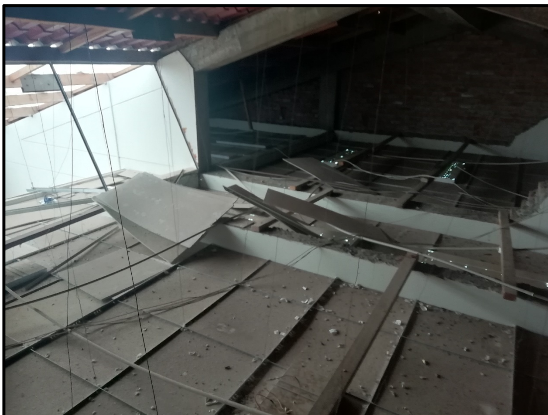
Foto 06: Cielorraso Existente cubierto de Polvo.
