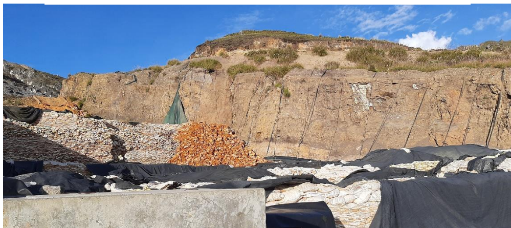
Fotografía N° 2. Talud en donde se instalará la cobertura con geosintéticos
