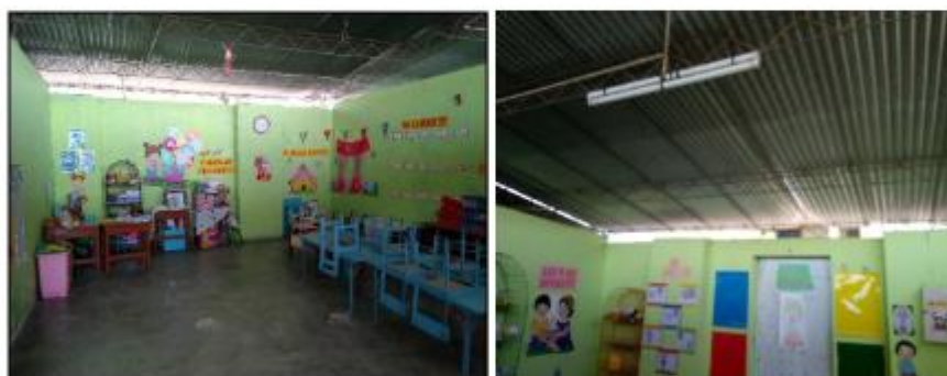
VISTAS DE LAS AULAS DESDE SU INTERIOR, CUYAS INSTALACIONES ELÉCTRICAS Y COBERTURA DE CALAMINA LIVIANA SE ENCUENTRAN EN MAL ESTADO DE CONSERVACIÓN
