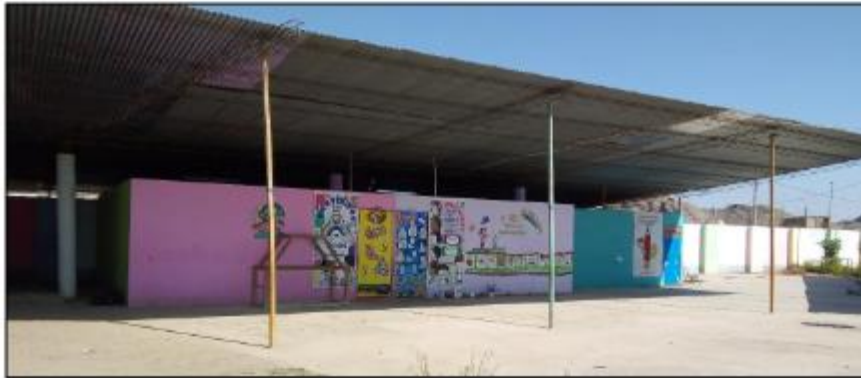
VISTA FRONTAL DEL PABELLÓN CONFORMADO POR TRES AULAS PEDAGÓGICAS, CUYOS MUROS ESTAN DIVIDIDOS POR TRIPLAY Y EN MAL ESTADO DE CONSERVACIÓN
