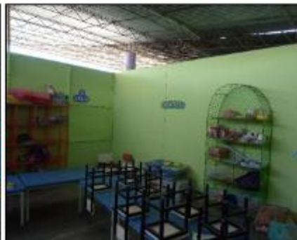
VISTA EXTERIOR E INTERIOR DE LAS AULAS PEDAGÓGICAS, CUYA COBERTURA DE CALAMINA LIVIANA FORMA PARTE DEL TECHADO DEL PATIO; OBSERVÁNDOSE DE MANERA ANTIESTÉTICA Y NO FUNCIONAL LAS ABERTURAS EN LA PARTE SUPERIOR DE LOS MUROS DE TRIPLAY
