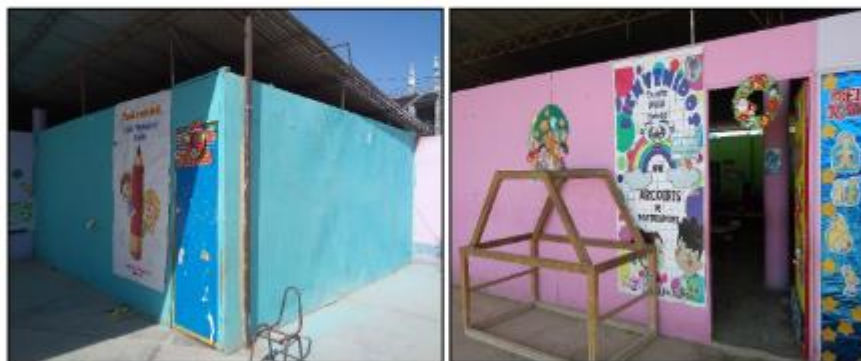
VISTAS LATERALES DE LAS AULAS CONSTRUIDAS A BASE DE TRIPLAY, CUYO ESTADO DE CONSERVACIÓN NO ES ÓPTIMO Y ADECUADO PARA SU USO
