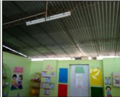
VISTAS INTERIORES DE LAS AULAS PEDAGÓGICAS, CUYAS INSTALACIONES ELÉCTRICAS Y COBERTURA DE CALAMINA LIVIANA SE ENCUENTRAN EN MAL ESTADO DE CONSERVACIÓN
