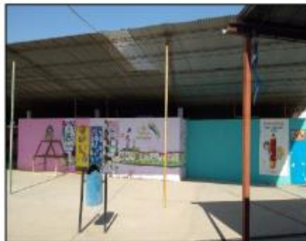
VISTA EXTERIOR E INTERIOR DE LAS AULAS PEDAGÓGICAS, CUYA COBERTURA DE CALAMINA LIVIANA FORMA PARTE DEL TECHADO DEL PATIO; OBSERVÁNDOSE DE MANERA ANTIESTÉTICA Y NO FUNCIONAL LAS ABERTURAS EN LA PARTE SUPERIOR DE LOS MUROS DE TRIPLAY
