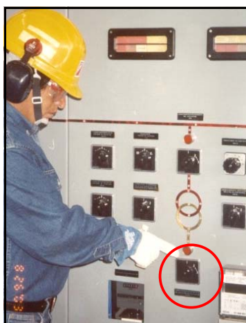
CONMUTADOR DE ACCIONAMIENTO DEL CONTACTOR DE EXCITACION
