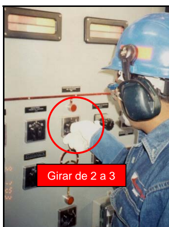
CONMUTADOR DE ACCIONAMIENTO DEL DISYUNTOR
