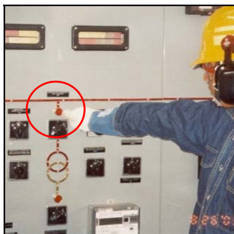
CONMUTADOR DE ACCIONAMIENTO DEL DISYUNTOR
