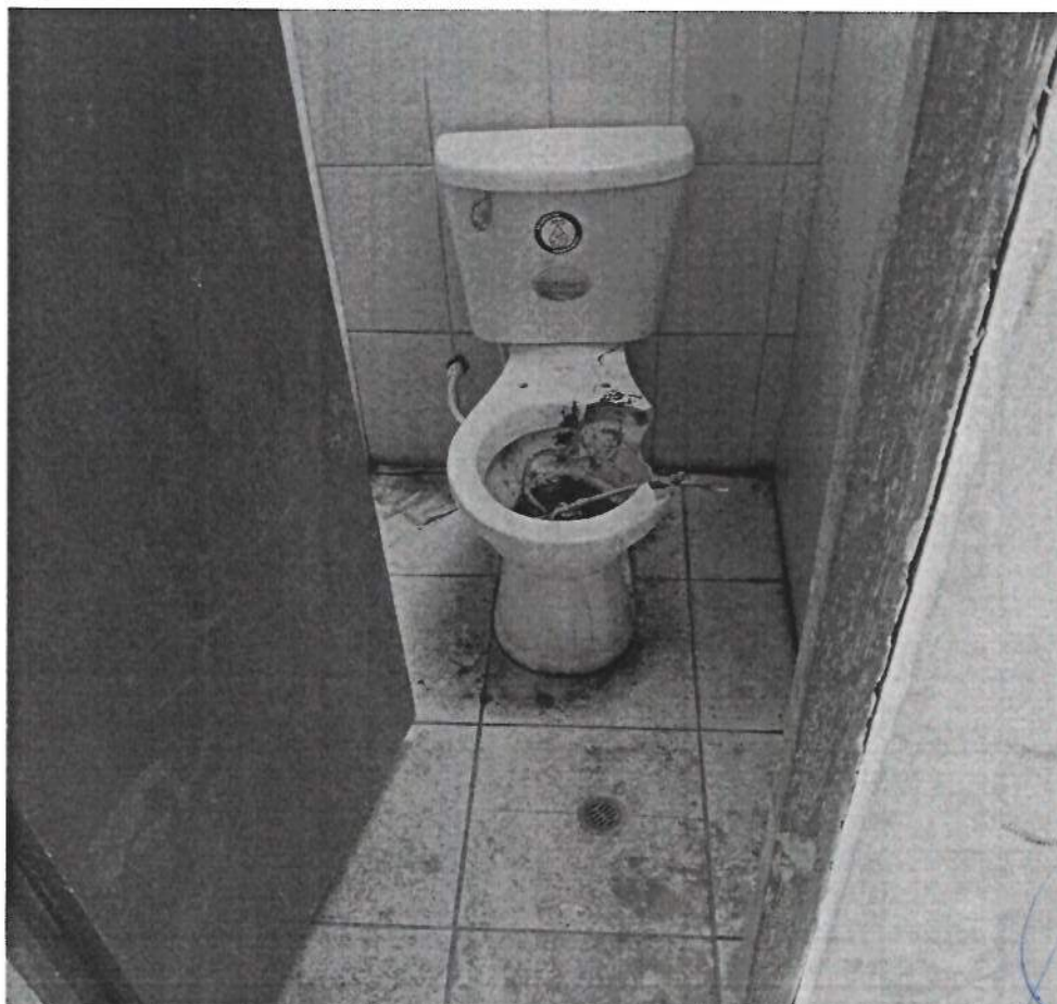
Foto N° 02: Vista Interior. Inodoro para sustituir. Desagüe colapsado.
