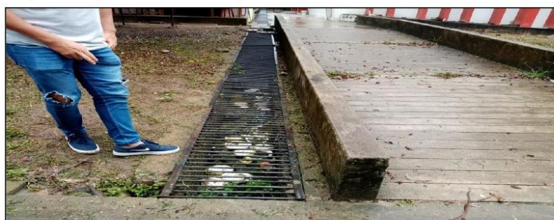
Inoperatividad de las cunetas producto del excesivo arrastre de partículas suspendidas (arena, basura, otros)
