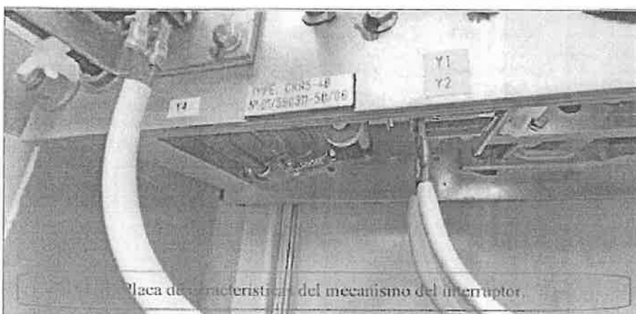
Placa de características de interruptor de potencia 170 kV
