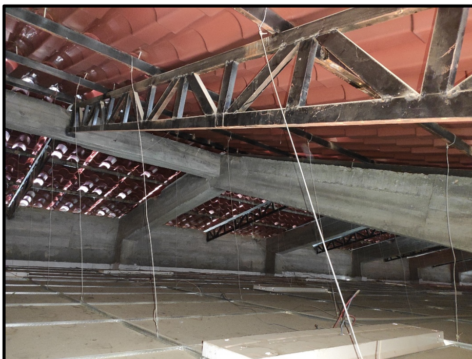
Foto 04: Estructura Metálica Tipo Celosía Existente de tubos rectangulares de 1"x2".
