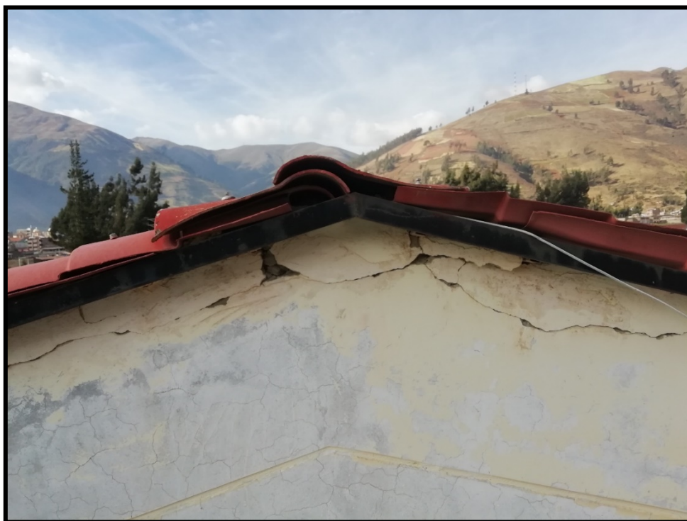
Foto 01: Borde Superior de Muros Dañada y Fragmentada, se recomienda picar las partes afectadas y resanar con concreto.
