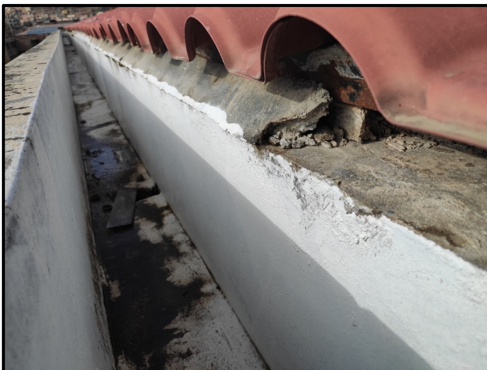
Foto 05: Canal de Agua Pluvial, desprendimiento de concreto entre Canal de Agua Pluvial y Cubierta existente, se recomienda picar y reemplazar concreto.
