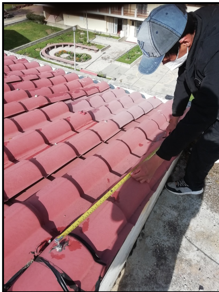
Foto 03: Toma de Datos en la Cubierta Existente.
