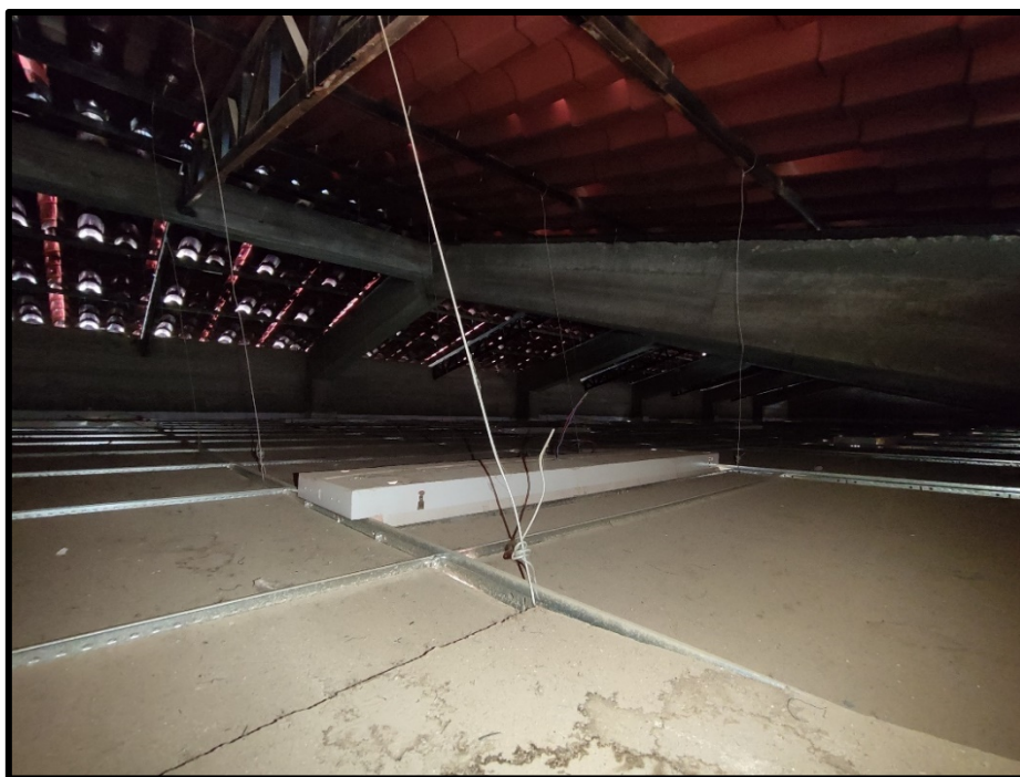
Foto 07: Cielorraso existente cubierto de polvo, perfiles principales sujetos por alambre de soporte.
