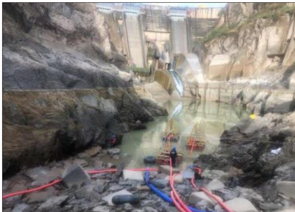
Foto 2 Trabajos de Bombeo de Poza de Disipación vista desde aguas abajo
