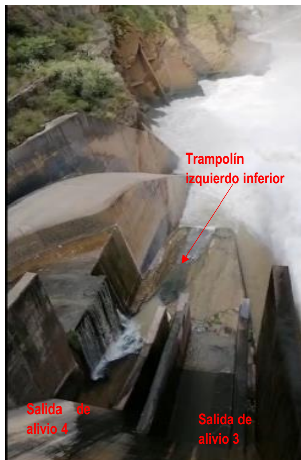
Figura 7 Salida del Alivio 4 y 3, aguas abajo de la Presa Tablachaca
