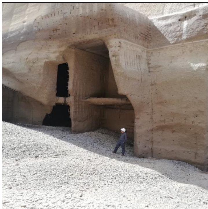
Foto 8 Daños en Trampolín Derecho vista desde aguas abajo
