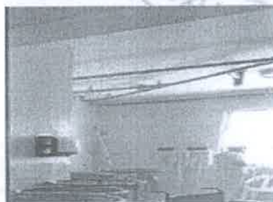
IMAGEN 17: TUBERIAS SANITARIAS EXPUESTAS, Rocio O. Cahuana ARQUITECTO CAP 4079
