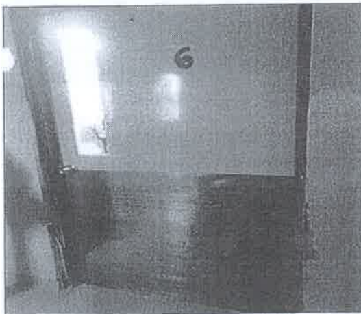
IMAGEN 01: DETERIORO Y DESGASTE EN EL MARCO Y PUERTA A CAUSA DE LA FALTA DE MANTENIMIENTO.
