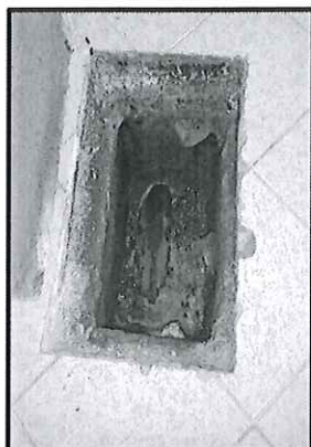
Cajas de registro deterioradas.
