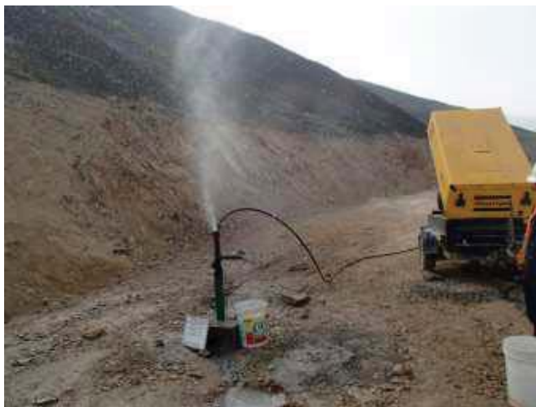
Figura 9: Expulsión de agua con aire comprimido
