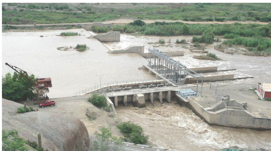
Bocatoma La Puntilla: Sobre el río Chancay – Lambayeque; Capacidad de derivación: 92 m 3 /s.
