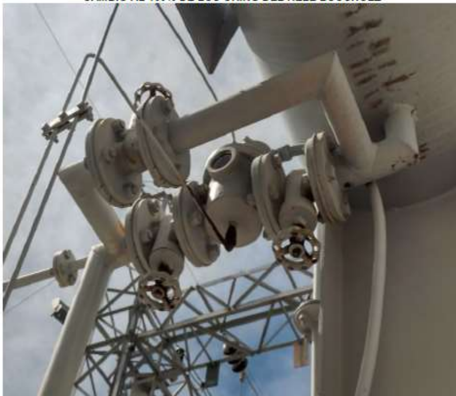
CAMBIO AL 100% DE LOS ORING DEL RELE PRESIÓN SUBITA DEL CBC
