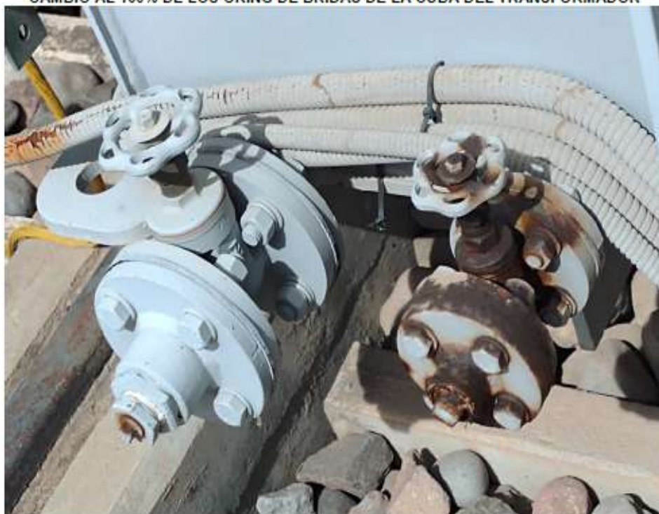
CAMBIO AL 100% DE LOS ORING DE BRIDAS DE LA CUBA DEL TRANSFORMADOR
