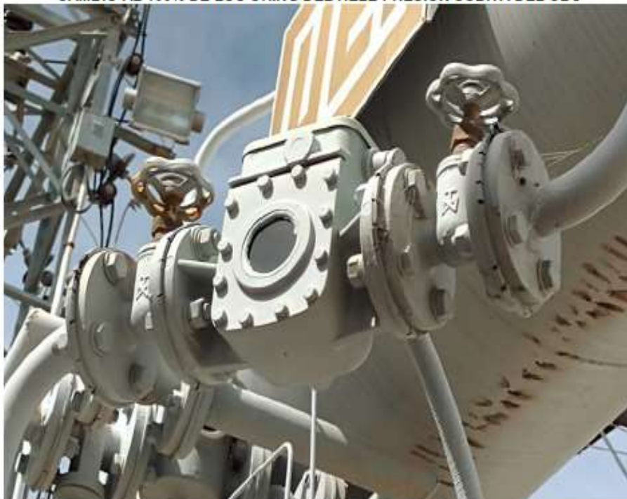
CAMBIO AL 100% DE LOS ORING DEL RELE PRESIÓN SUBITA DEL CBC
