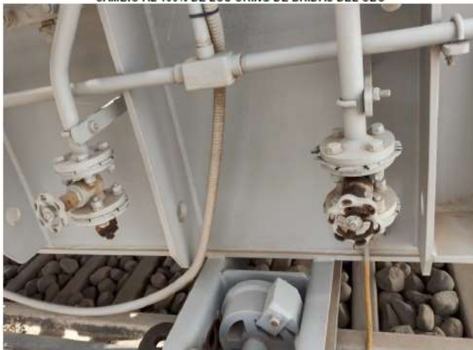
CAMBIO AL 100% DE LOS ORING DE BRIDAS DE LA CUBA DEL TRANSFORMADOR
