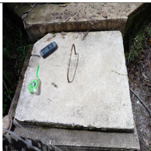
VISTA PANORÁMICA DE LA SEGUNDA CAPTACIÓN. SE OBSERVA TAPA SANITARIA EN MALAS CONDICIONES DE CONSERVACIÓN.
