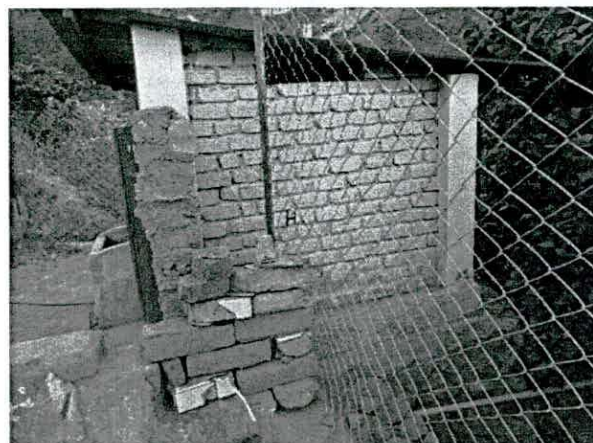
Si bien es cierto la I.E cuenta con SS.HH este tiene una antigüedad de 23 años, y la infraestructura va cediendo ya que no cuenta con cimentación además de encontrarse en el borde de un acantilado.
