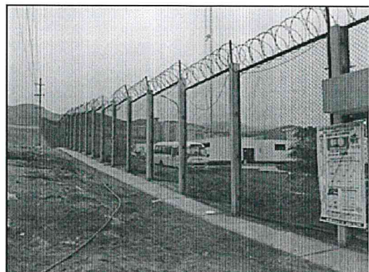
PINTADO DE ESTRUCTURA TUBULAR Y ANGULOS DE CERCO METALICO EN INGRESO PRINCIPAL (H=3.75m, ANCHO MARCO MALLA=2.75m) - NO INCLUYE NUEVOS CERCOS
