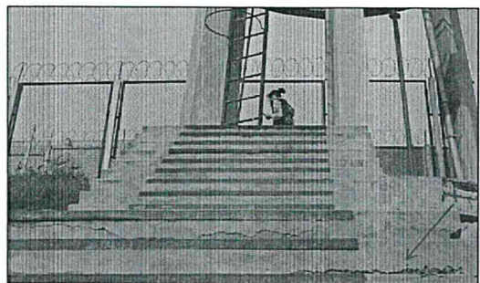
MANTENIMIENTO DE ESCALERAS Y COLUMNAS/LOSA DE PISO DE RESERVORIO ELEVADO DE AGUA (Ver esquemas Estructurales)
