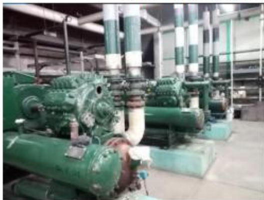
Grupos frigoríficos instalados en la C.H Charcani V
