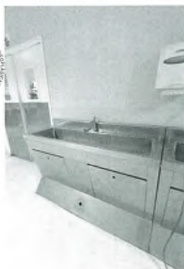
Fotografía N° 06: cambio de grifería y pedal de pie para los lavatorios de acero inoxidable existente en Centro Quirúrgico debido a que se necesita mayor altura de grifería.
