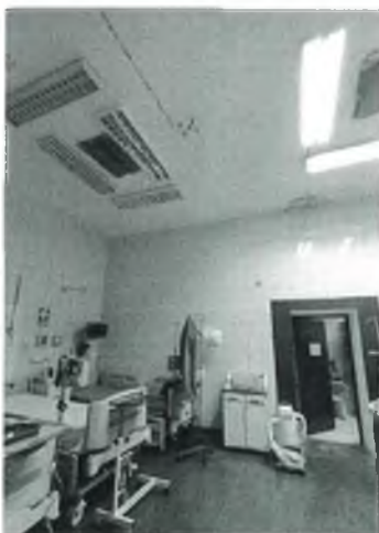
Fotografía N° 04: Instalación de falso cielo raso, cambio de luminarias, mantenimiento de aires acondicionados y ventilación dentro de los ambientes de URPA.
