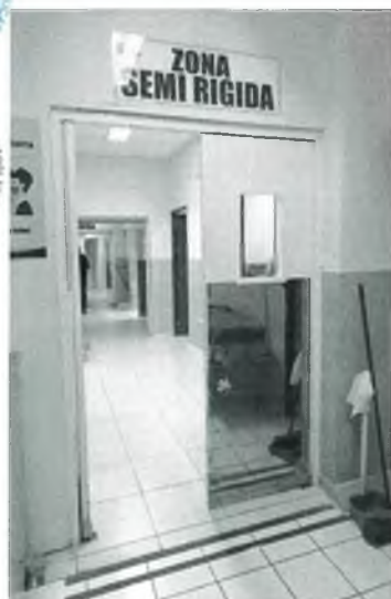
Fotografía N° 12: Puertas de una y doble hoja que requieren de mantenimiento como pintado, cambio de bisagras, cambio de puerta en su totalidad.
