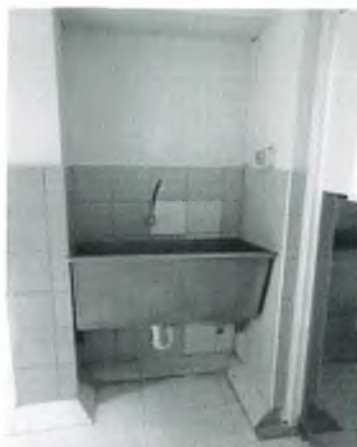
Fotografía N° 07: Retiro de lavatorio de acero inoxidable de una poza en Centro Quirúrgico para luego enchapar de cerámica la pared.
