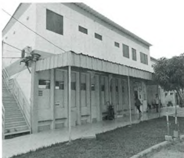
Fotografía N° 15 y N° 16 Cobertura metálica y su respectiva estructura metálica a exteriores de Patología Clínica, con presencia de óxido y se encuentra desgastado.
