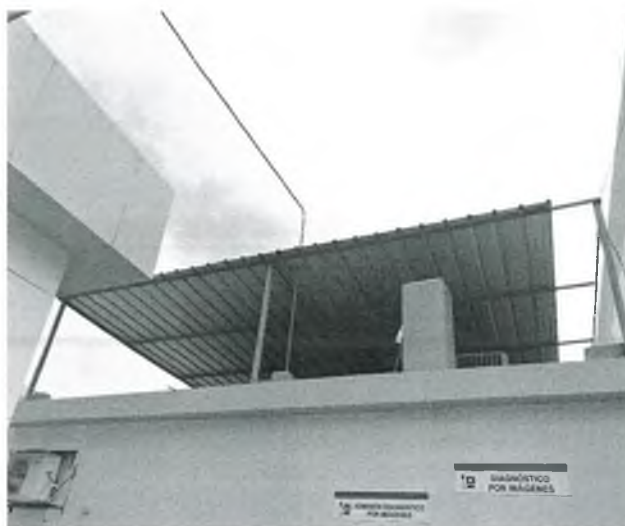
Fotografía N° 17 Cobertura metálica y su respectiva estructura metálica a exteriores de Anatomía Patológica en el segundo piso, se encuentra desgastado para mantenimiento y es necesario de incrementar su altura para brindar mejor trabajabilidad de los equipos mecánicos.
