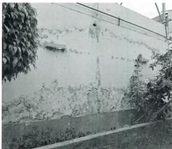
Fotografía N° 11 Presencia de humedad y salitre en muros, por lo que se requiere el resane total.
