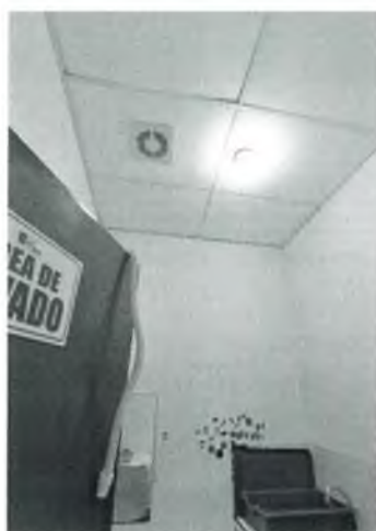
Fotografía N° 03: Luminaria que no brinda la suficiente iluminación se cambiará por panel led en distintos ambientes mencionados en el metrado. Además del cambio de falso cielo raso.
