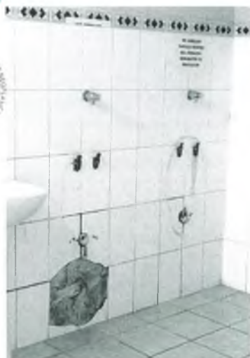
Fotografía N° 10: Accesorios de urinarios instalados para retirarlos y posterior instalación de todo el aparato de urinario incluyendo sus accesorios, así mismo el retiro de todo el enchapado de los baños tanto de damas como de caballeros.
