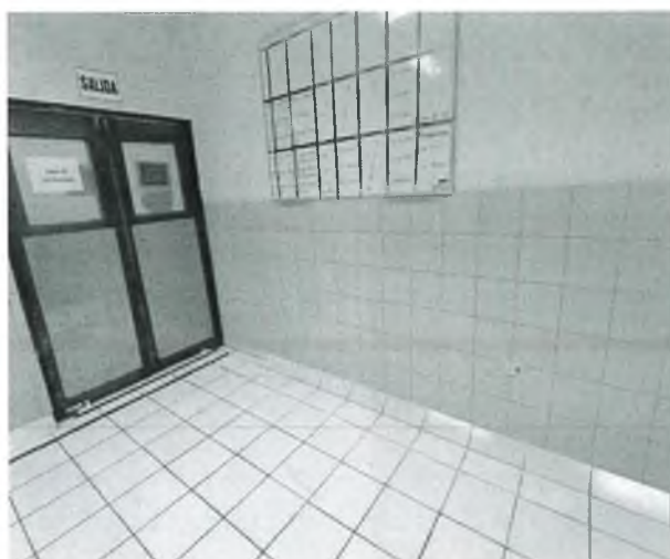
Fotografía N° 05 Cambio de cerámico a porcelanato en el piso, zócalos y contra zócalo en la UPSS Hospitalización.
