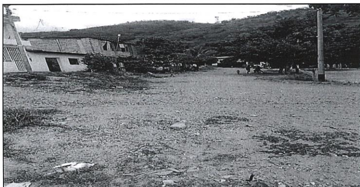
Imagen 07: Presencia de baches y ligeros desniveles en toda la vía, en épocas de lluvia la vía se hace intransitable
