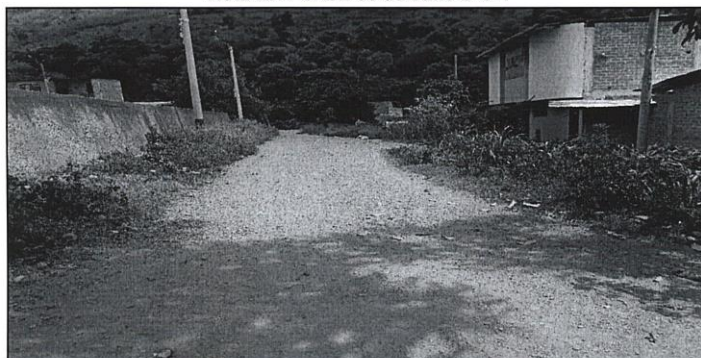
Imagen 08: Presencia de baches y ligeros desniveles en toda la vía, en épocas de lluvia la vía se hace intransitable
