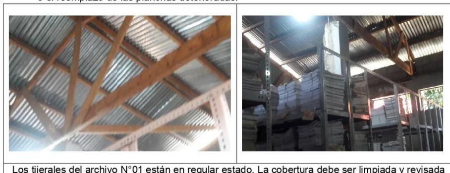
Los tijerales del archivo N°01 están en regular estado. La cobertura debe ser limpiada y revisada
