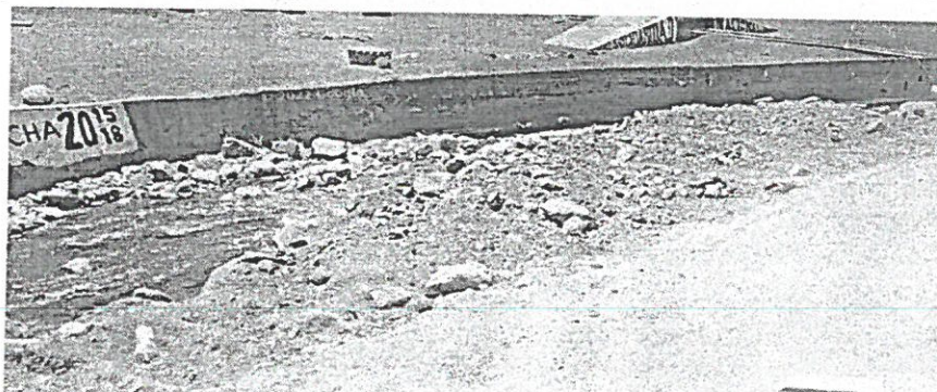
En la imagen se visualiza, la falta de muro de contención para proteger la vía en la
