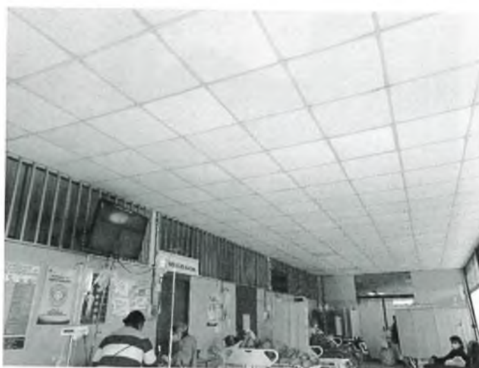
Fotografía N° 03: Cielo raso a retirar dentro del ambiente actual "Triaje" incluyendo el desmontaje de las instalaciones eléctricas (luminarias, tomacorrientes e interruptores).
