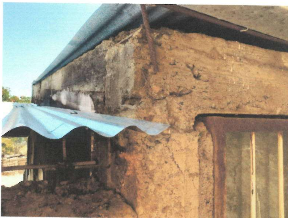
Foto N° 03: vista exterior de las vigas y columna, la viga del lado izquierdo presenta fisuras debido a una junta de construcción probablemente por el proceso constructivo, se observa cangrejas en el concreto algunas fisuras en la columna en la zona del encuentro con la viga, el acero de la viga se encuentra expuesto con oxido y no cuenta con un adecuado anclaje, teniendo en consideración la antigüedad de la edificación y la autoconstrucción, como medida preventiva se recomienda la demolición y construcción de la edificación.
