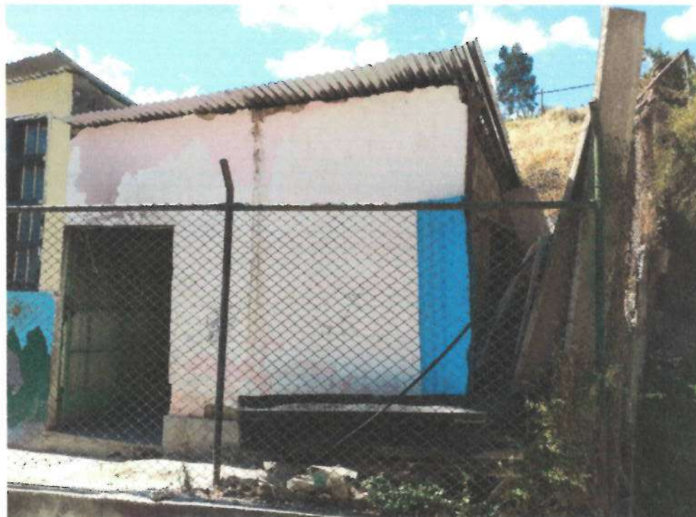
Foto N° 01: vista exterior de la edificación de adobe, las paredes se encuentran con presencia de humedad
