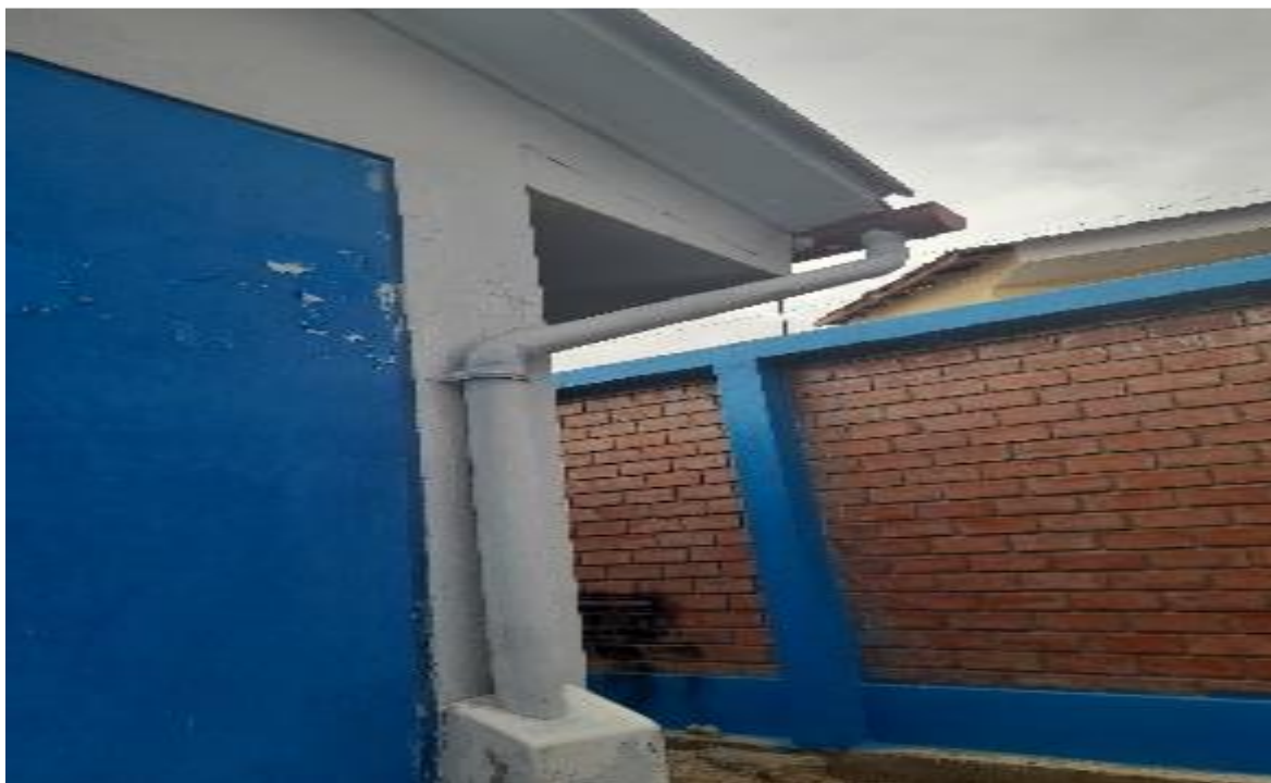
FOTO N° 10: Vista panorámica, Las canaletas de drenaje pluvial están construidas con plancha de acero galvanizado, tienen montantes de tubería de PVC que llegan a falsas columnas al nivel del terreno. La vereda, tiene canaletas laterales con una protección de rejilla de acero pintada.
