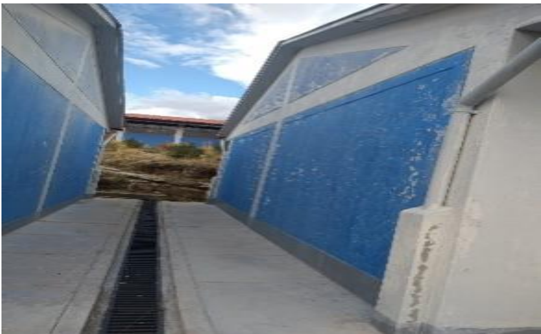
FOTO N° 18: vista panorámica de la vereda exterior y la cuneta de concreto con rejilla en buen estado, los montantes pluviales se encuentran en buen estado, intersección del Módulo II y Modulo III.
