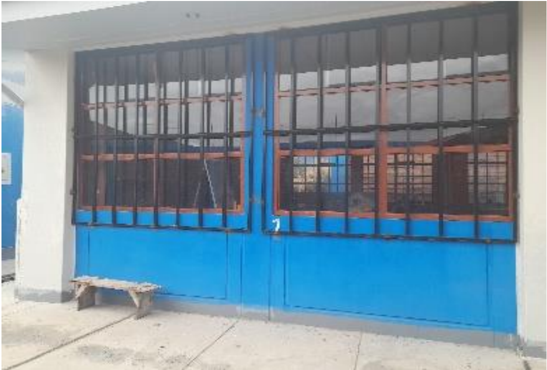
FOTO N° 17: Vista panorámica, de las ventanas, tiene estructura de aluminio tipo madera con protección metálica, su estado de conservación es buena.
