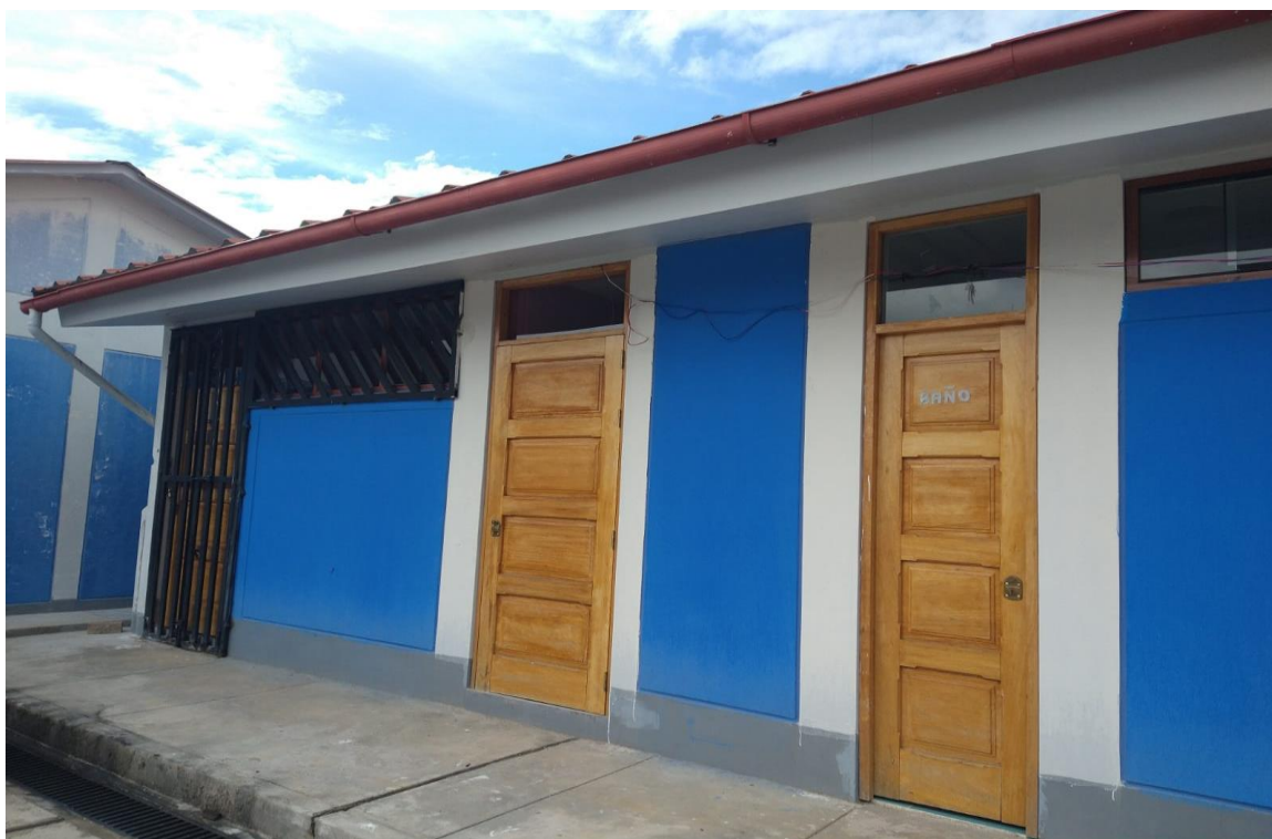
FOTO N° 4: Vista panorámica, del Módulo I (Dirección, SSHH, Tópico, Deposito) con una antigüedad de unos 03 años de antigüedad, cuenta con un sistema estructural de albañilería confinada con pórticos de concreto armado, su conservación es buena, no se intervendrá con acondicionamiento y confort térmico.
