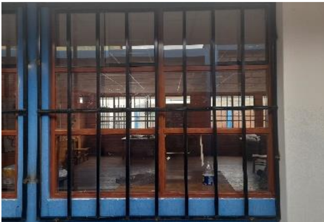
FOTO N° 24: Vista panorámica de las ventanas de estructura de aluminio color madera, con vidrio simple transparente fijados en sus cuatro lados al marco metálico de la ventana. Presenta rejillas
