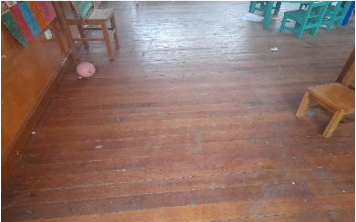
FOTO N° 21: Vista panorámica del piso de madera machihembrado y zócalo de madera de aula en estado regular, del Módulo III.(Aula 01)
