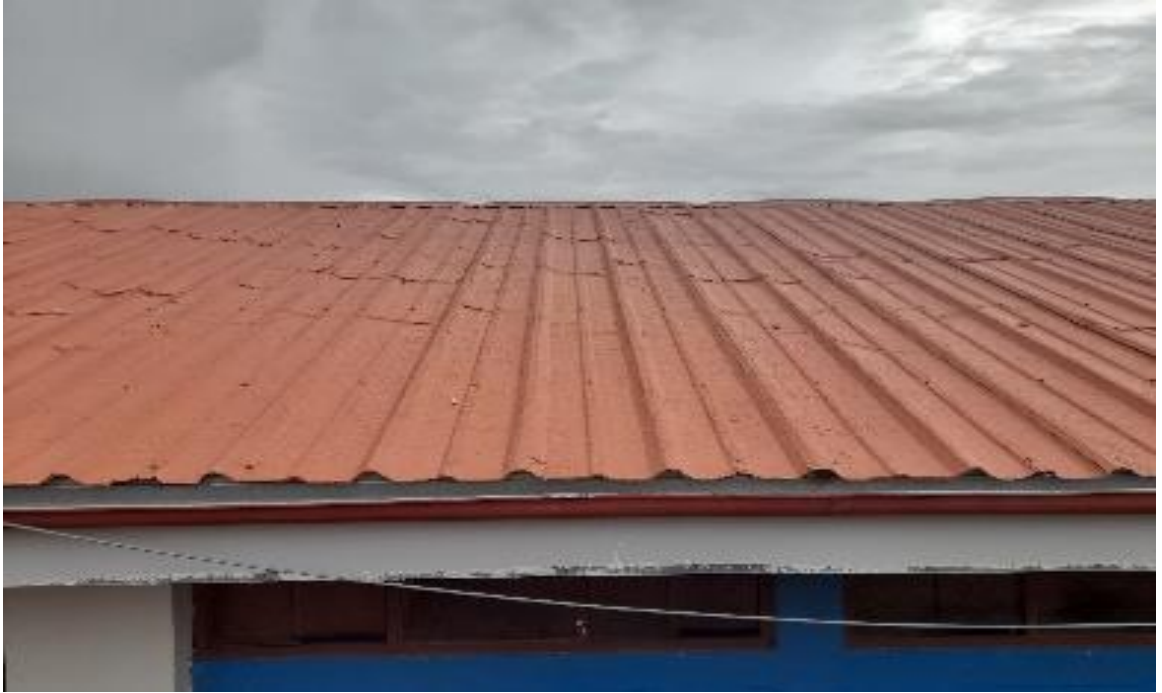
FOTO N° 7: Vista panorámica, del techo y cobertura del Módulo I es de estructura metálica tipo articulada, con planchas de aluzinc, inclinado a dos aguas., su estado de conservación es buena.
