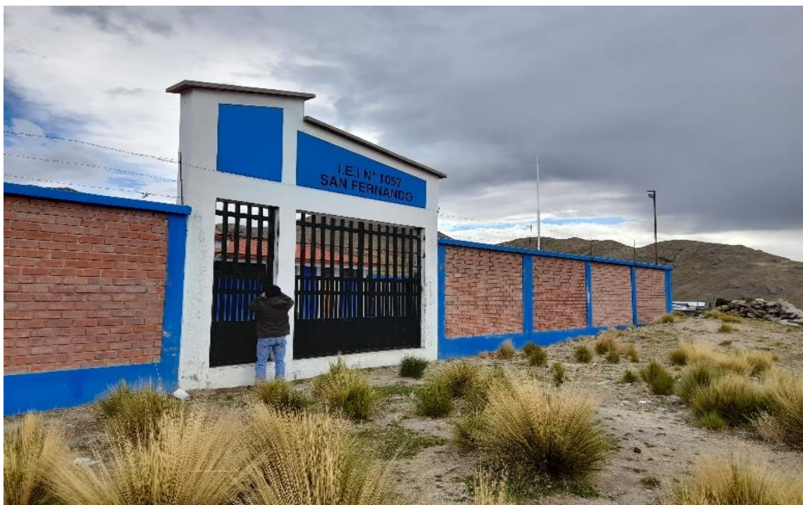
FOTO N° 1: Vista panorámica, del ingreso principal de la I.E.1057-San Fernando, se encuentra construido de albañilería confinada y puerta de reja metálica.
