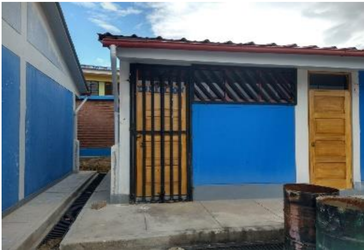
FOTO N° 9: Vista panorámica, de las puertas del Módulo I, son de tablero rebajado, con acabado natural, cuyo sentido de apertura es en dirección de la evacuación. Abre hacia afuera.
