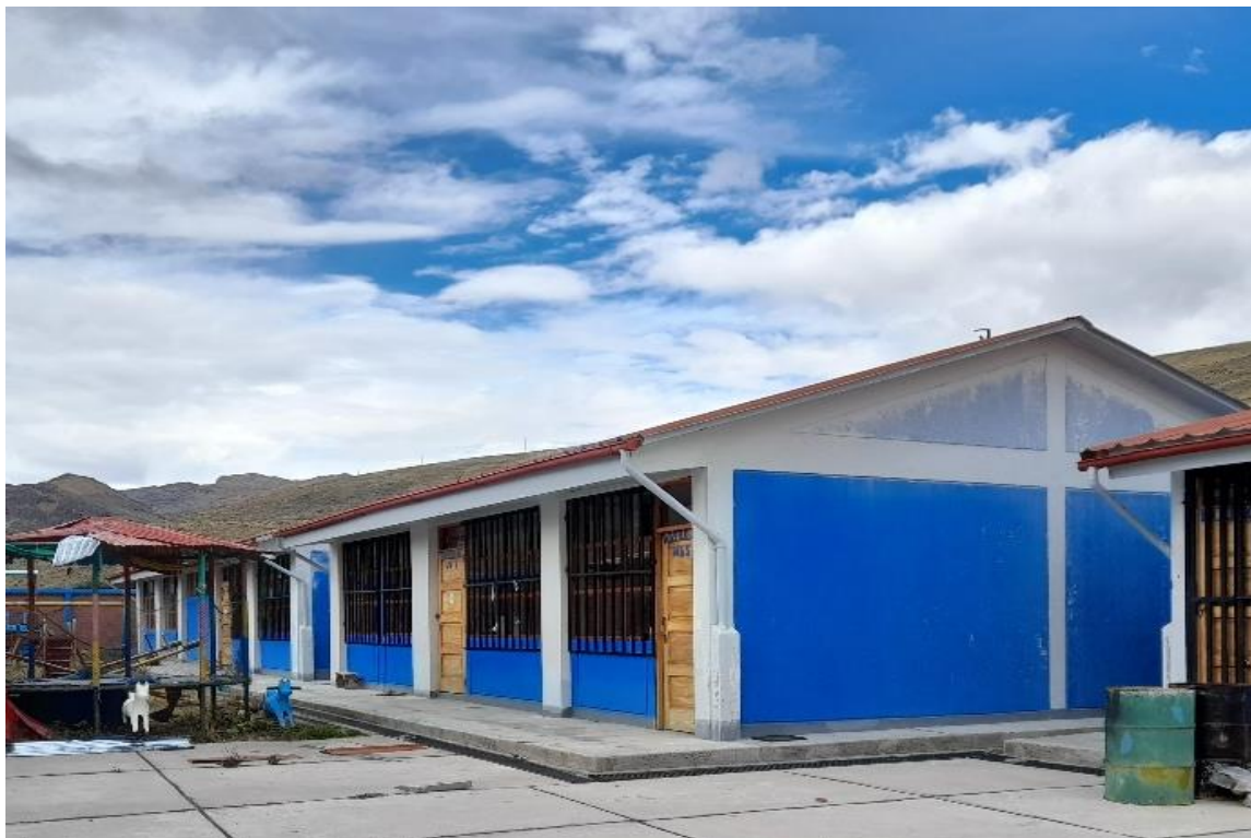
FOTO N° 11: Vista panorámica del Módulo II (cocina, dormitorio y aula), Este Bloque cuenta con 03 ambientes destinados una cocina, un dormitorio y un Aula que actualmente de usa como comedor, con una antigüedad no es más de 3 años, posee sistema estructural de albañilería confinada con pórticos de concreto armado se encuentra en buen estado, no se intervendrá el aula.
