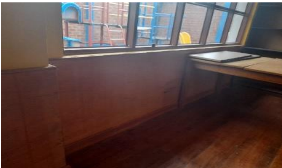
FOTO N° 12: Vista panorámica del piso de madera machihembra y zócalo de madera de h= 10cm, los muros tienen un zócalo de triplay barnizado de h= 0.90m su estado de conservación es regular, en comedor (aula)
