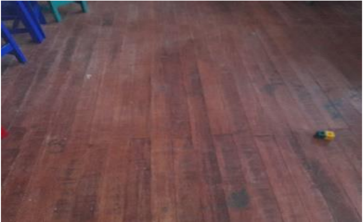
FOTO N° 5: Vista panorámica, del piso de madera machihembrado del Módulo I (Dirección), su estado de conservación es regular.
