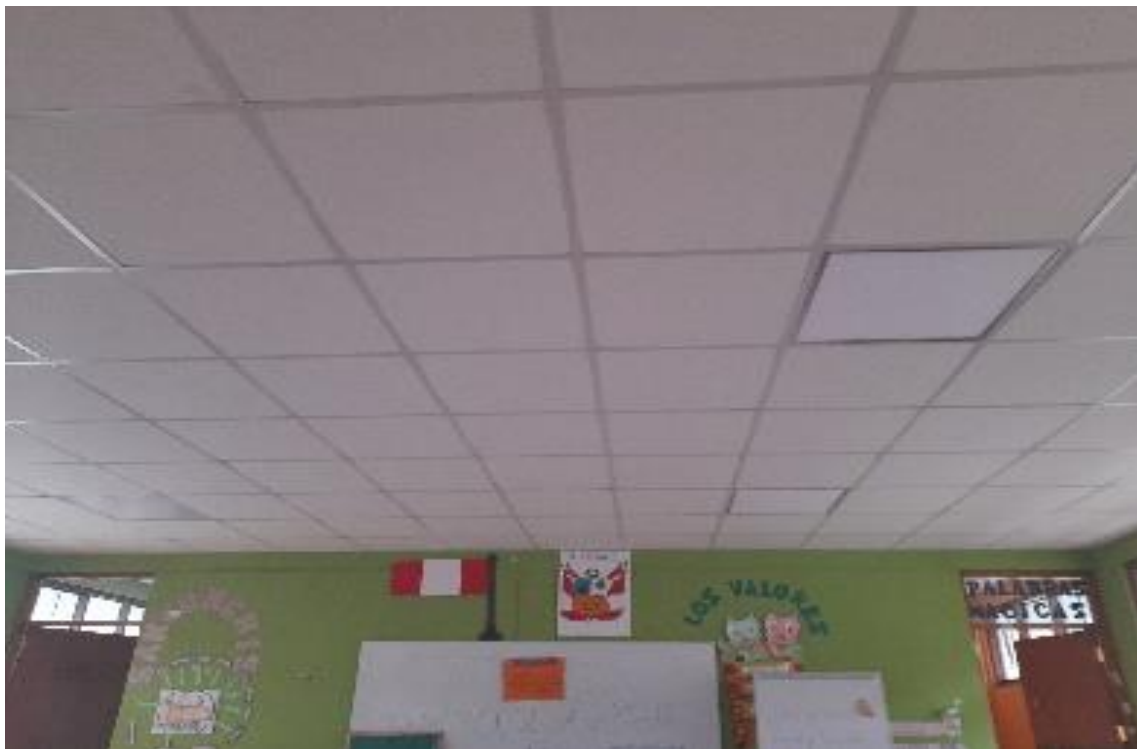
FOTO N° 23: El falso cielorraso está estructurado en paneles acústicos con perfilaría metálica, su estado de conservación es regular, corresponde al Aula 1 del Módulo III.
