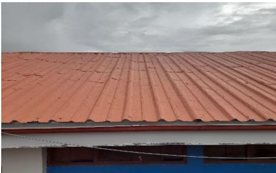
FOTO N° 14: Vista panorámica, de la cobertura del Módulo II, posee estructura metálica tipo articulada, con planchas de aluzinc, inclinado a dos aguas, su estado de conservación es buena.
