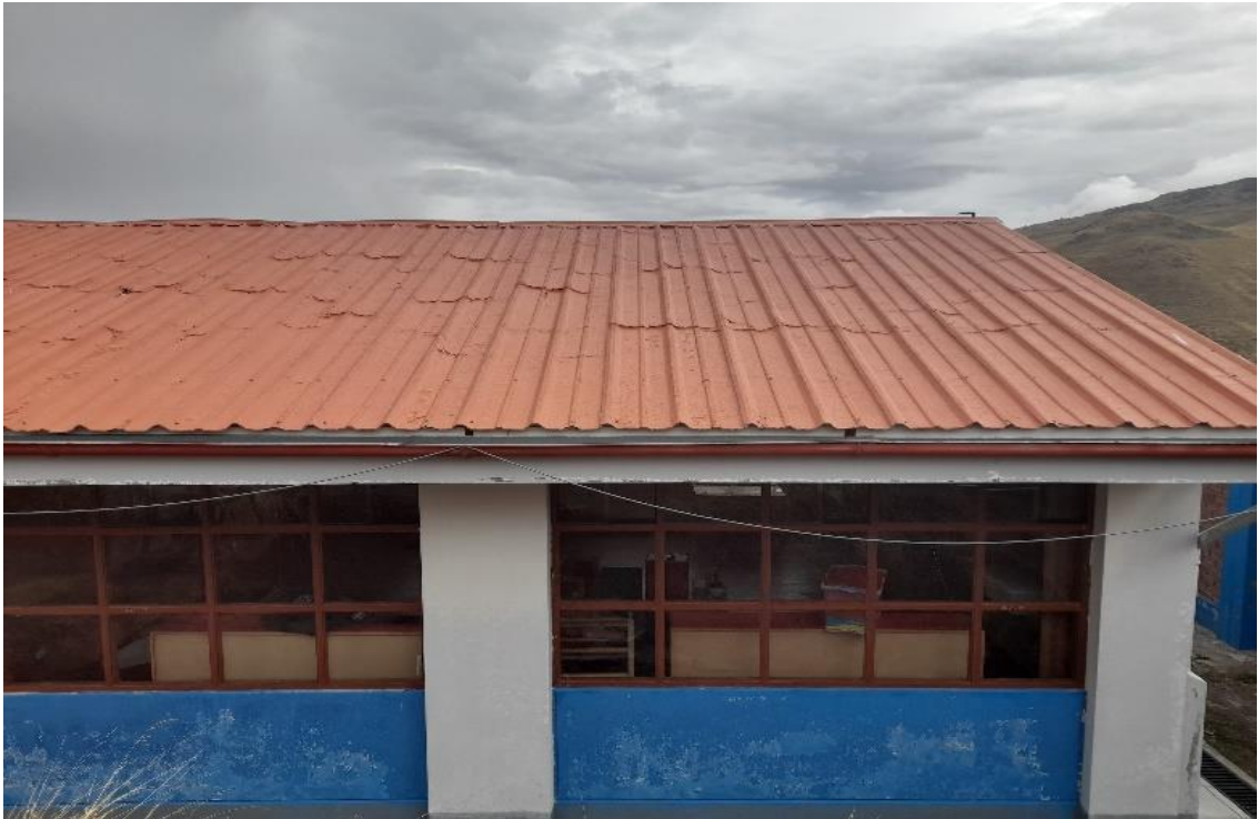
FOTO N° 19: Modulo III, Cuenta con cobertura de estructura metálica tipo articulada, con planchas de aluzinc, inclinado a dos aguas, su conservación es buena.
