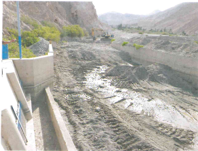
Vista de los muros de encauzamiento aguas arriba del barraje, del canal desgravador y el alfeizar de las ventanas de captación de la bocatoma Chuschuco
