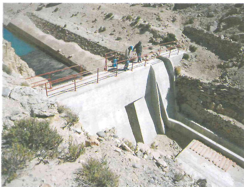
Vista del cuerpo de la presa Casiri aguas abajo. Se observa el mecanismo de izaje, las barandas de protección y el vertedero de cresta libre.
