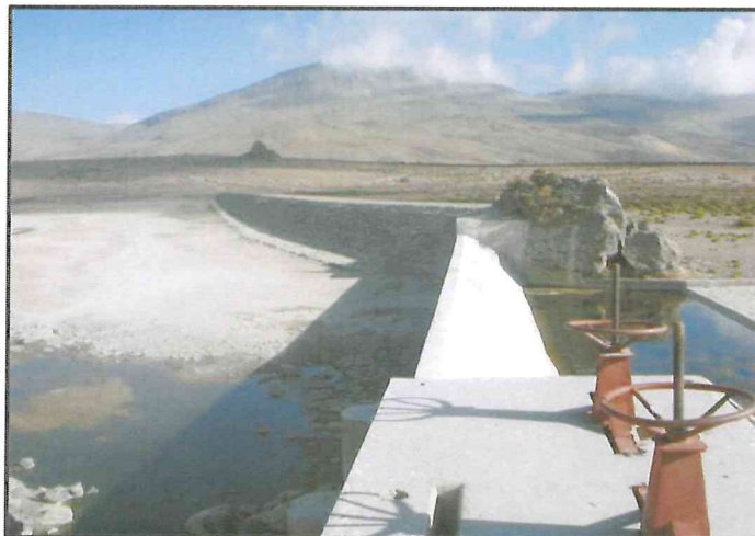
Foto N° 03.- Vista desde aguas abajo de las compuertas de descarga y aliviadero de demasía del Dique Cano.
