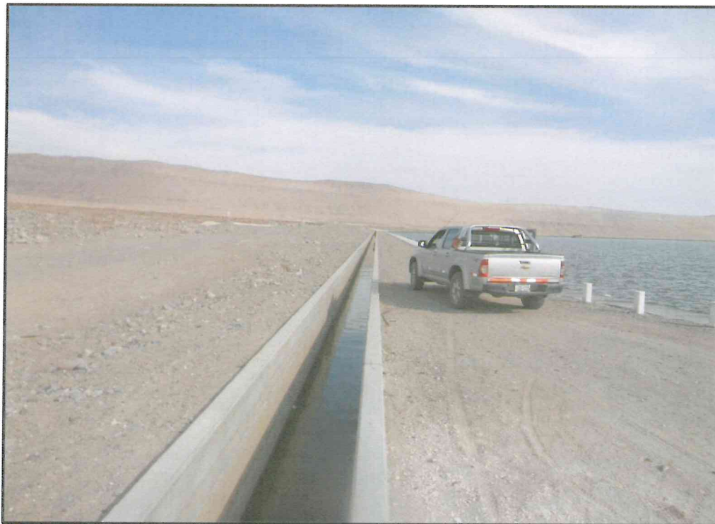
Foto Nº 05.- En la imagen se observa el canal de alimentación paralelo al Reservorio, el cual se encuentra recubierto con Geomembrana de polietileno de 60 milímetros de Espesor, con una protección de geotextil.
