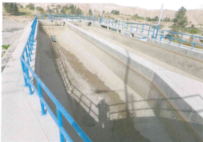
Vista del interior de las naves desarenadoras de la bocatoma Chuschuco.
