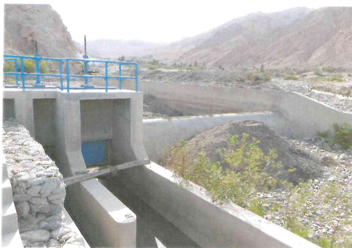
Vista aguas abajo del barraje y los canales de limpia y desripiador.
