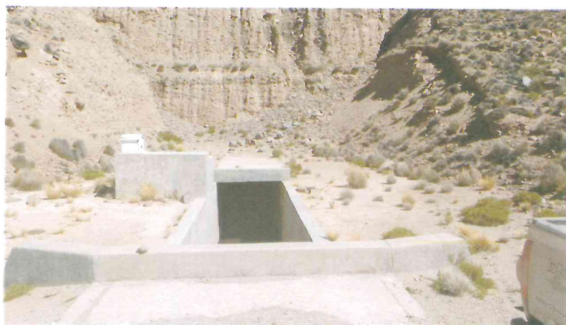
Zona de entrada al Túnel Kovire mostrando el tramo cubierto del canal de ingreso y los derrumbes en el afrontonamiento sobre el portal de entrada del túnel
