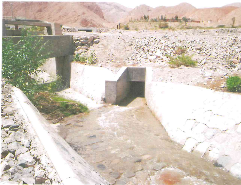
Vista de la salida del canal de purga vertiendo en la caja del antiguo canal
