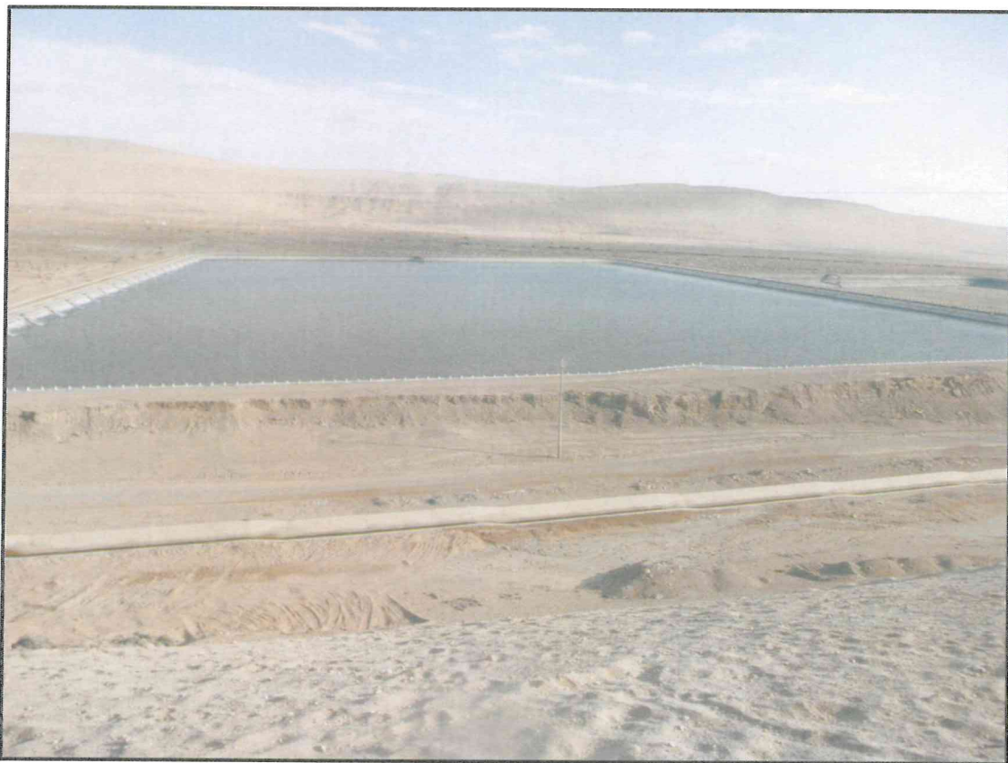
Foto Nº 17.- Se observa una de las pozas de almacenamiento de 320m. X 220 m. de área y 6 m. de profundidad, conformadas por excavaciones y terraplenes y recubierta con Geomembrana de polietileno de 1.50 milímetros de espesor, con una protección de geotextil.
