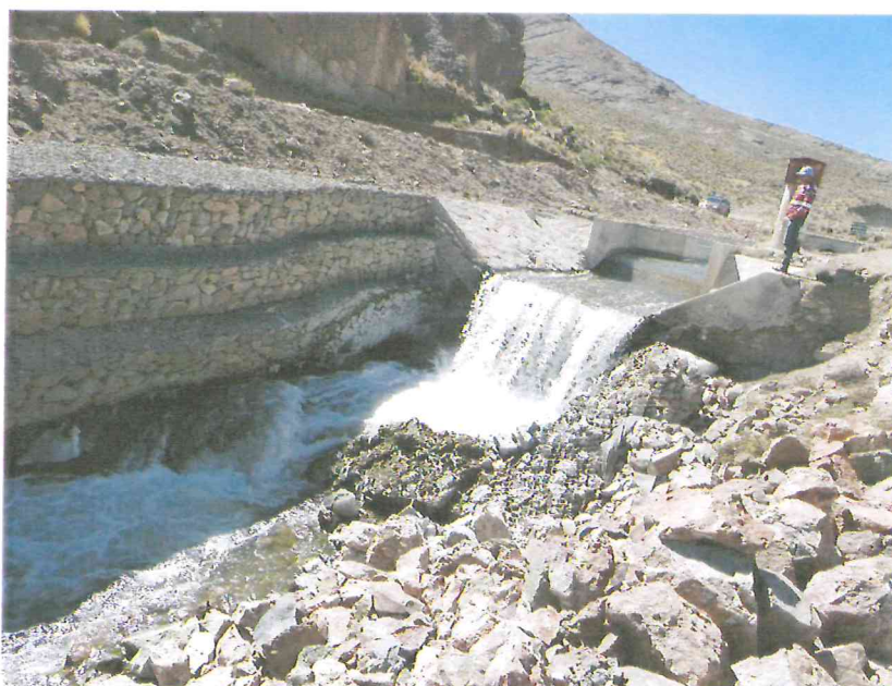
Vista del final del canal y del vertedero Parshall
