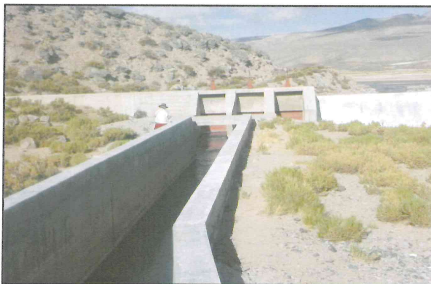
Foto N° 01.- Vista de la margen Derecha del Dique Cano. Se observa el Aliviadero de demasía y las compuertas de descarga
