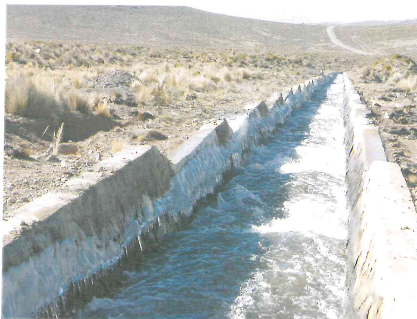
Vista de las graderías Patapujo aguas arriba del punto de entrega de los pozos, obsérvese los restos congelados del remanso en los taludes del canal
