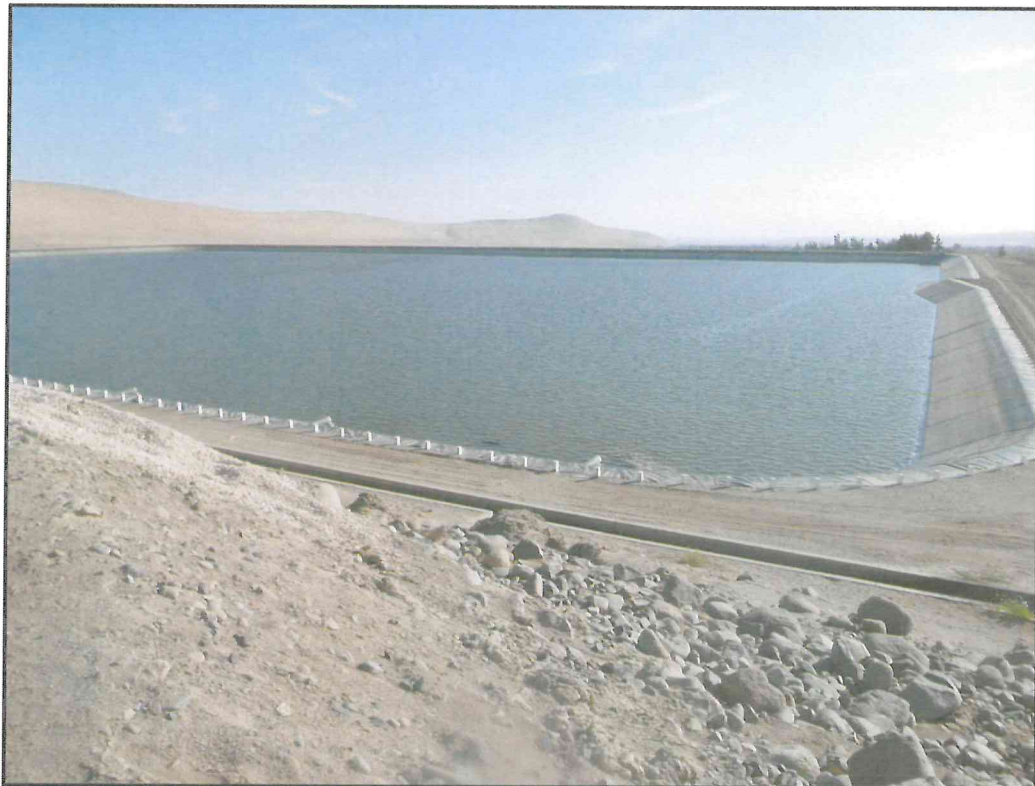
Foto N° 06.- Se observa una de las o tres pozas de almacenamiento de 320m. X 220 m. de Área y 6 m. de profundidad, conformadas por excavaciones y terraplenes y recubierta con Geomembrana de polietileno de 1.50 milímetros de espesor, con una protección de geotextil.
