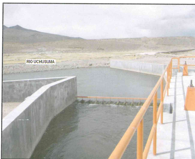
Foto N° 10.- Vista donde se aprecia la captación del rio Uchusuma a la bocatoma.
