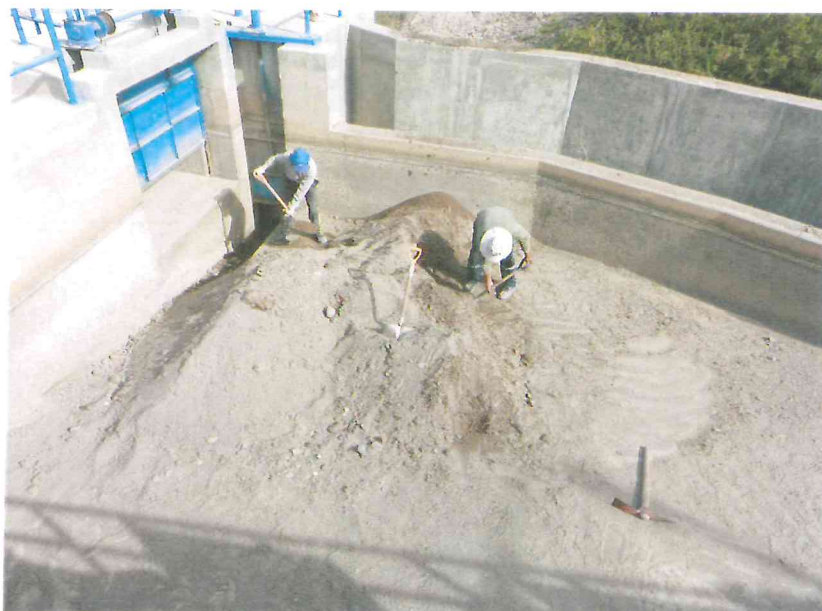
Vista de la limpieza del canal de acercamiento y del canal desripiador en la zona de captación de la bocatoma. Obsérvese el vertedero de demasías y las compuertas
