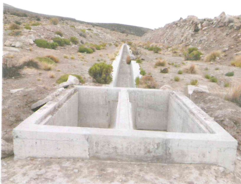
Vista del canal de derivación y de la cámara rompe presión 1 en el tramo inicial del Empalme Murmuntane, es apreciable la fuerte pendiente del tramo.
