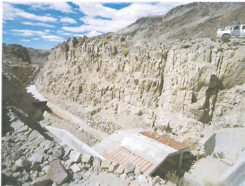
Vista de la caseta de válvulas y de las condiciones inestables del rajo donde se emplaza el canal de descarga de la presa Casiri
