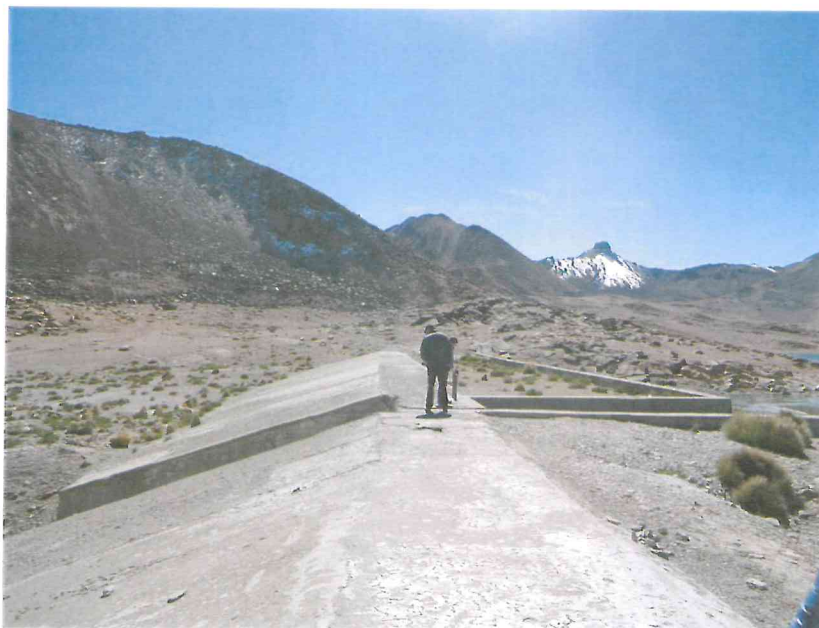
Vista de la corona del dique y de la pantalla de concreto aguas arriba de la presa Condorpico
