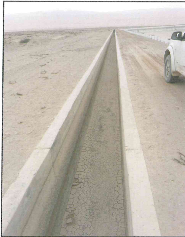
Foto N° 16.- En la imagen se observa el canal de alimentación paralelo al Reservorio, el cual se encuentra recubierto con Geomembrana de polietileno de 1.5 milímetros de espesor, con una protección de geotextil.
