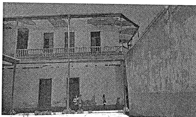
Foto N° 7.- Primer y segundo piso donde se observa el estado de las paredes así como el estado del balcón de madera apoyada en vigas de madera.
