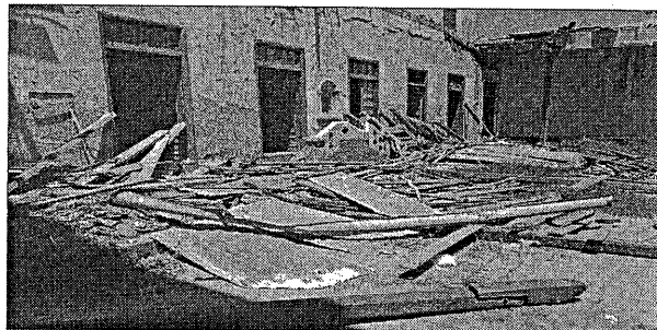
Foto N° 3 Pared del primer piso de adobe, vigas y viguetas de madera, y pared del segundo piso de madera con caña de Guayaquil chancada recubierta con techo de calamina en mal estado y con escombros de madera.
