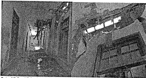
Foto N° 8 y N° 9.- Pared de adobe y techo colapsados por efecto de las lluvias del año 2017
