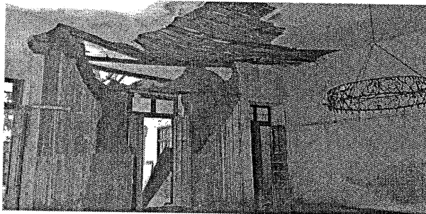
Foto N° 4.- Colapso de techo de guayaquil empastado con yeso, muros de adobe, puerta y linteles por las lluvias.
