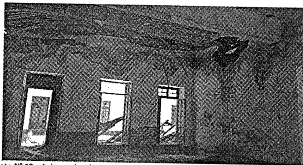
Foto N° 13.- Aula en alto riesgo por el colapso de techo de caña de guayaquil con torta de barro, yeso, pared de adobe con dinteles de puerta y ventana en alto riesgo.
