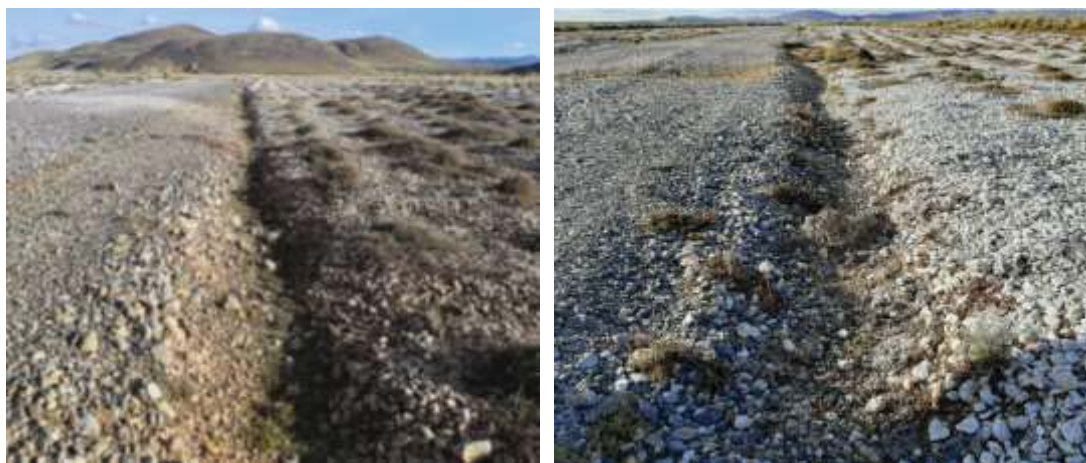
Figura N° 09: Cunetas de terreno natural en el delta Upamayo
