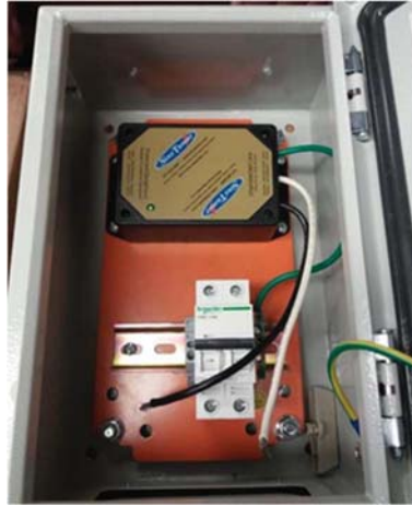
Modelo referencial de Supresor de Pico protegido en gabinete metálico
