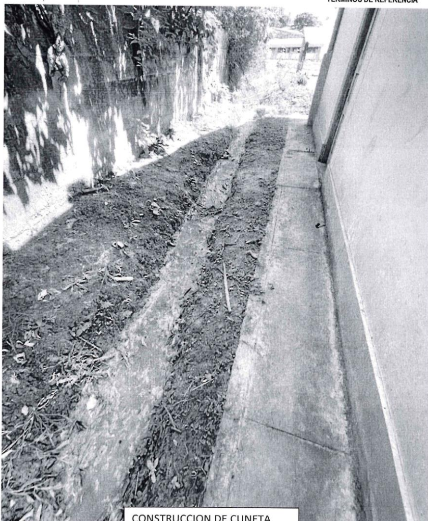
CONSTRUCCION DE CUNETA PARA DRENAJE PLUVIAL.
