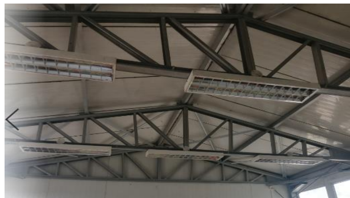
Ilustración 20: Luminarias tipo rejilla en aula prefabricada.
