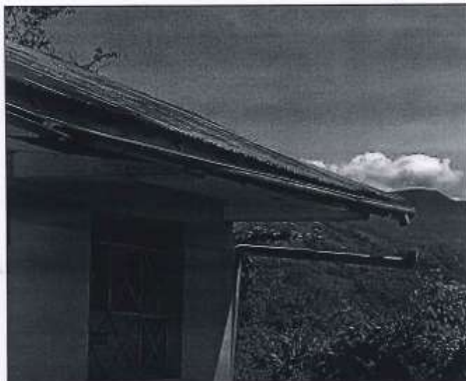
FOTO 03 – Se observa el mal estado de la canaleta y el techo de calamina el cual necesita ser cambiado.
