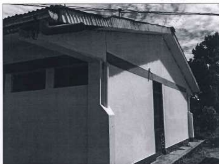
FOTO 04 – En la imagen se observa el mal estado de las tuberías montantes de bajada de agua de lluvia.
