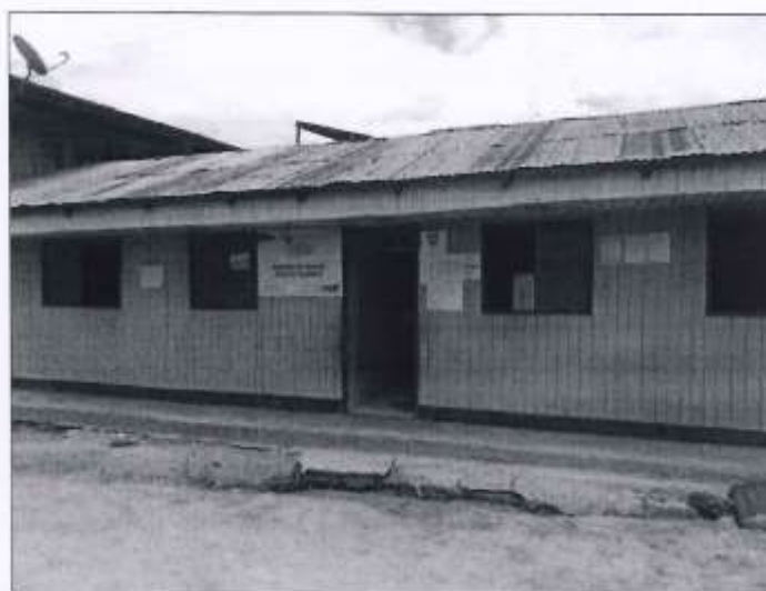
FOTO 02 – se observa el deterioro y mal estado de las calaminas
