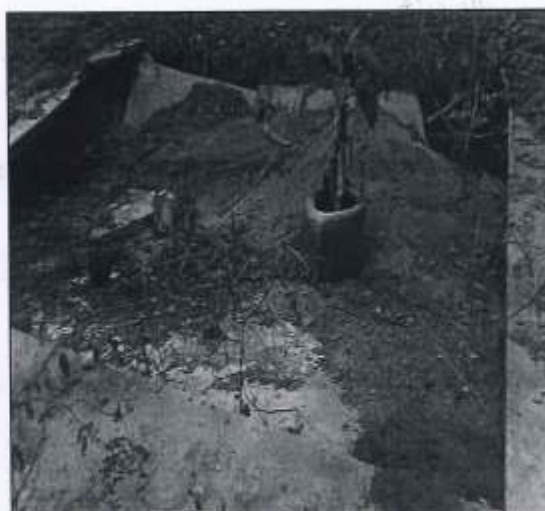
FOTO 04 – En la imagen se observa el hundimiento de pozo ciego.
