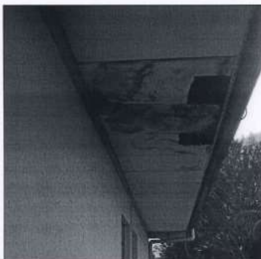
FOTO 02 – Se observa en la imagen el cielorraso en mal estado.
