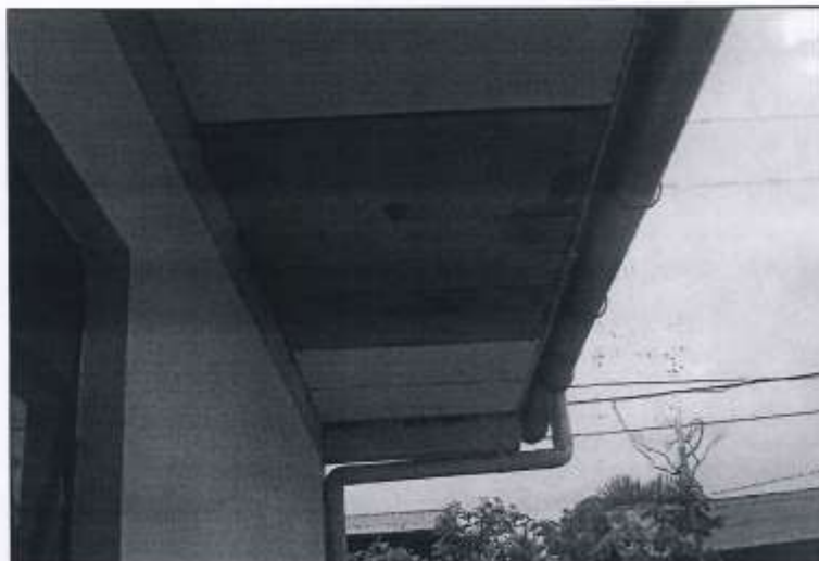
FOTO 03 – Se observa en la imagen el cielorraso en mal estado y la ausencia de artefactos de iluminación.
