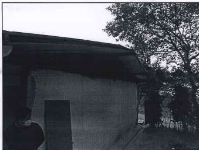
FOTO 01 – En la imagen se observa el deterioro del cielorraso exterior y la falta de pintado de muro exterior.
