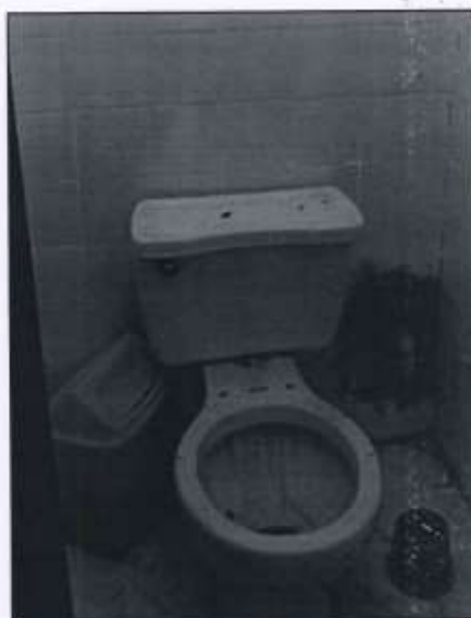
FOTO 02 – Se observa los accesorios de los aparatos sanitarios en mal estado.
