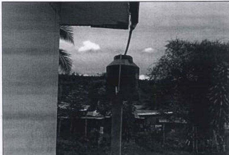
FOTO 02 – Tanque elevado de agua (Eternit), no está abasteciendo de agua a los aparatos sanitarios.
