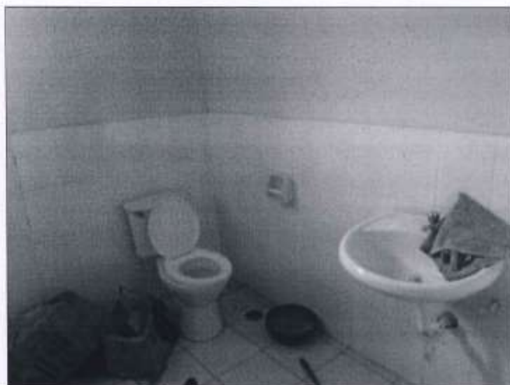
FOTO 03 – En la imagen se observa los accesorios sanitarios en mal estado.
