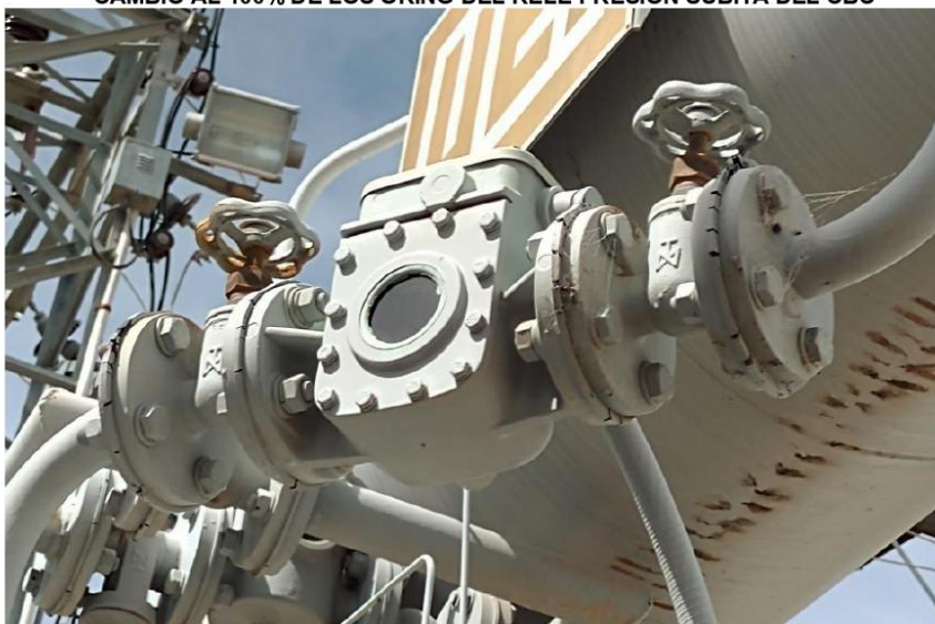
CAMBIO AL 100% DE LOS ORING DEL RELE PRESIÓN SUBITA DEL CBC
