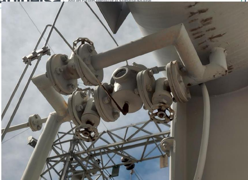
CAMBIO AL 100% DE LOS ORING DEL RELE PRESIÓN SUBITA DEL CBC
