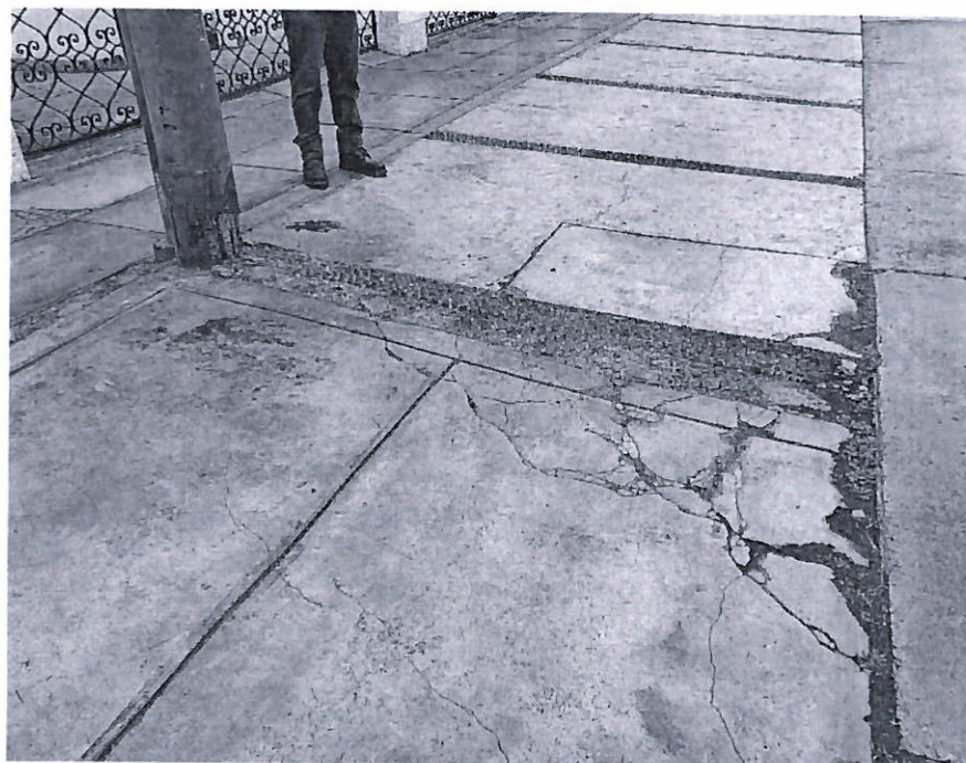
Desgaste excesivo de bermas laterales en la vía por falta de mantenimiento adecuado
