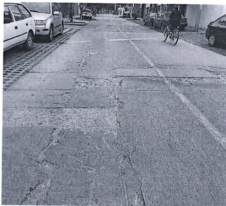
Grietas y desgaste de la capa de rodadura de la vía vehicular
