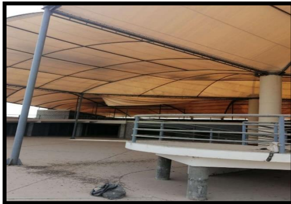
Falta de templado en cobertura de lona
