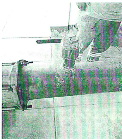
Figura 05. Válvula de alivio
