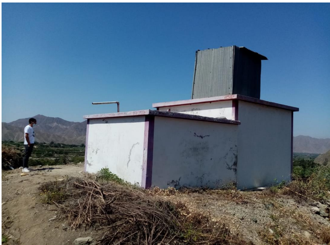
Foto N°14: Estado actual de reservorios, vista panorámica. Se aprecia la no existencia de cerco perimétrico. Sistema de cloración cerrado y en estado precario.
