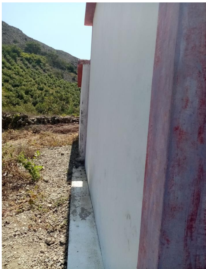
Foto N°13: Estado actual de reservorios, pintura en mal estado.
