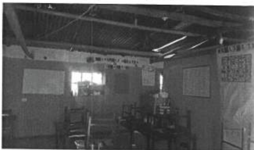
Foto N° 02: Se visualiza la falta de vigas collarin para la unión entre cobertura y muros, falta de luminarias en el interior y división de Tryplay entre el aula y el almacén.
