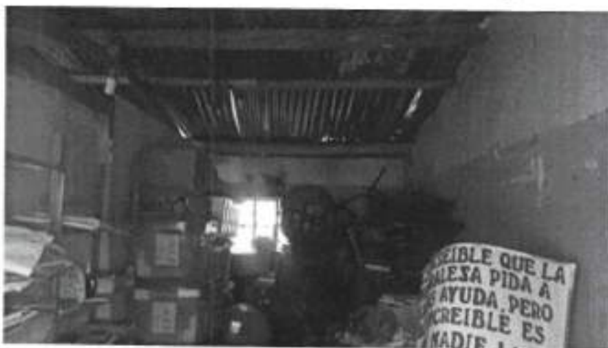
Foto N° 02: Se visualiza la falta de vigas collarin para la unión entre cobertura y muros, falta de luminarias en el interior y división de Tryplay entre el aula y el almacén.
