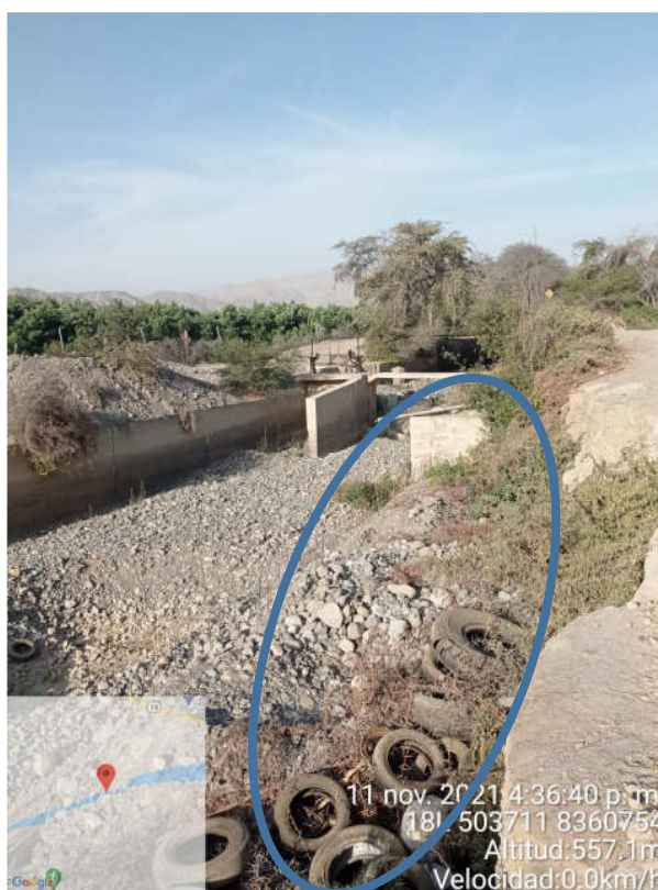
Pilas de neumáticas atenuar la socavación a la vía
