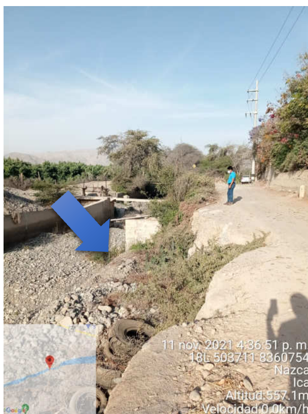
Pilas de neumáticas y ramas para atenuar la socavación a la vía
