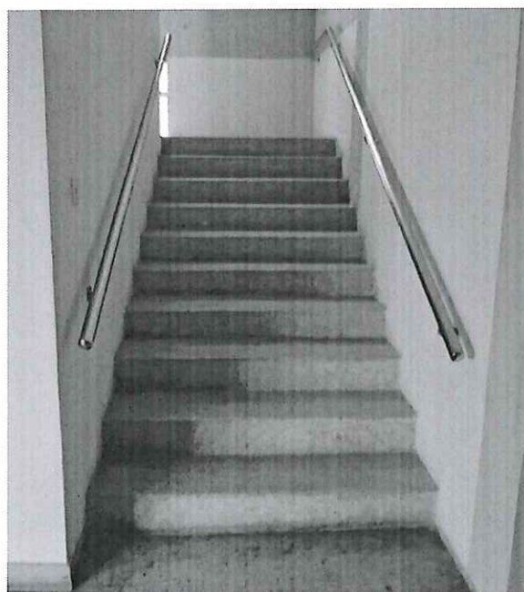
Escaleras de granito en mal estado y con cantoneras antideslizantes inexistentes.
