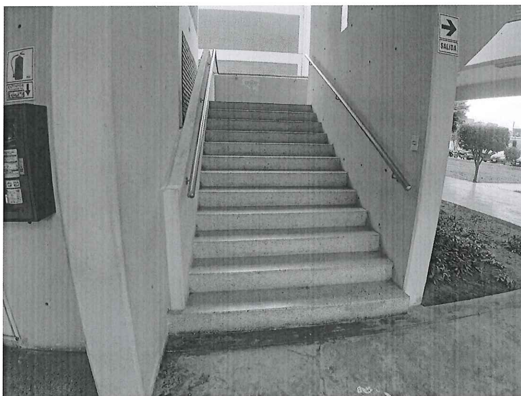
Escaleras de granito en mal estado y con cantoneras antideslizantes inexistentes
