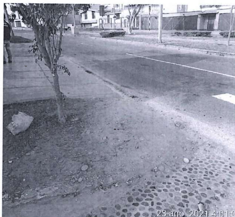
Falla por agrietamiento y desprendimiento de la superficie de rodadura de rampas laterales ubicadas en varios tramos de la vía.
