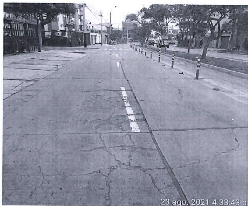
Agrietamiento y desgaste excesivo de superficie de rodadura en varios tramos de la vía.
