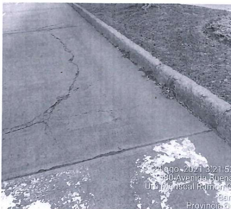
Grietas y excesivo desgaste de la capa de rodadura de la vía vehicular ubicada en la progresiva 0+100.00m
