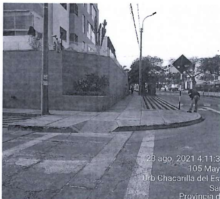
Grietas y excesivo desgaste de la capa de rodadura de la vía vehicular. También se observa trabajos de canalizaciones ubicada en la progresiva 0+0.00m
