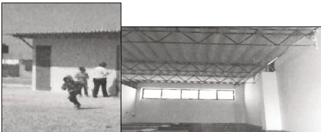
Vistas fotográficas N° 03 y 04.- Vista del frontis del Pabellón 03 Servicio Higiénico y su interior vigas metálicas y cobertura de planchas de calamina.
