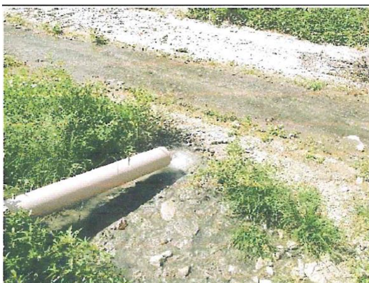
Fotografía N°02 Laguna de oxidación colapsada y el emisor en descarga de agua residual
