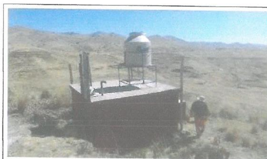
Fotografía N° 04: Vista panorámica ubicación de captaciones de manantes en el sector de Sinua. Existen 05 ojos de manante que se usan en la actualidad, y todos se encuentran en las mismas condiciones, es decir completamente enterrados, por el paso de los años los accesorios se encuentran deteriorados o simplemente no existen.
