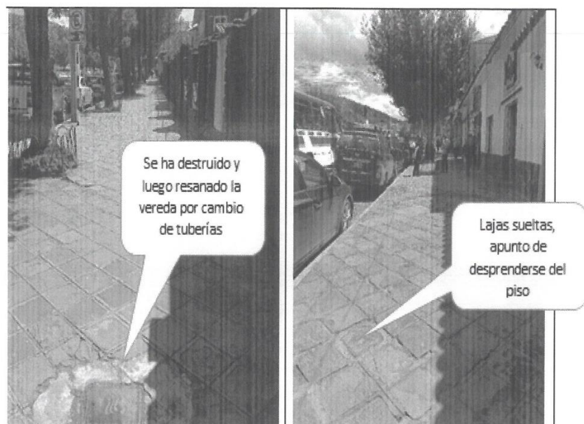
Vista N° 5: En la imagen se aprecia otra vista del deterioro existente en las veredas perimetrales de la Av. Pardo donde se evidencia la falta de juntas entre las losetas de piedra y el deterioro ocasionado por las nuevas instalaciones de agua potable, entre otras.
